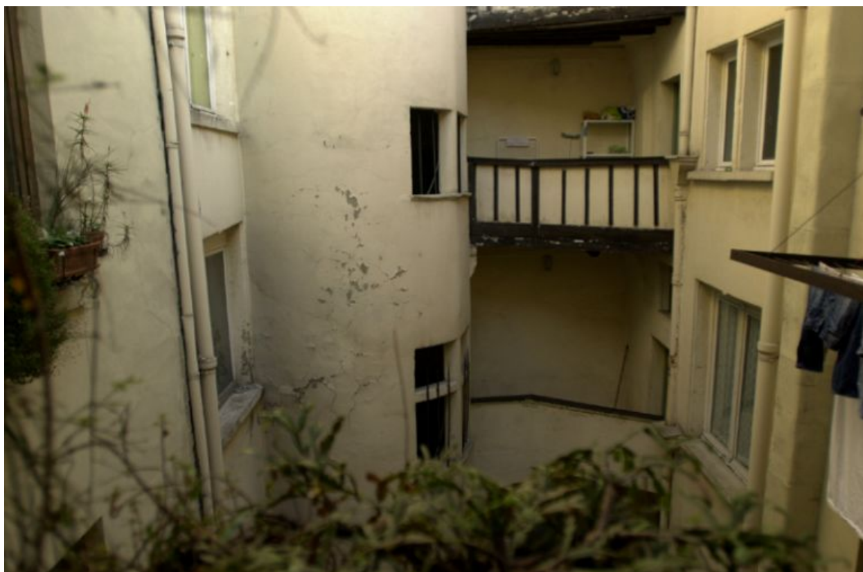
Cour, tour d'escalier et coursières des 3e et 4e étages
