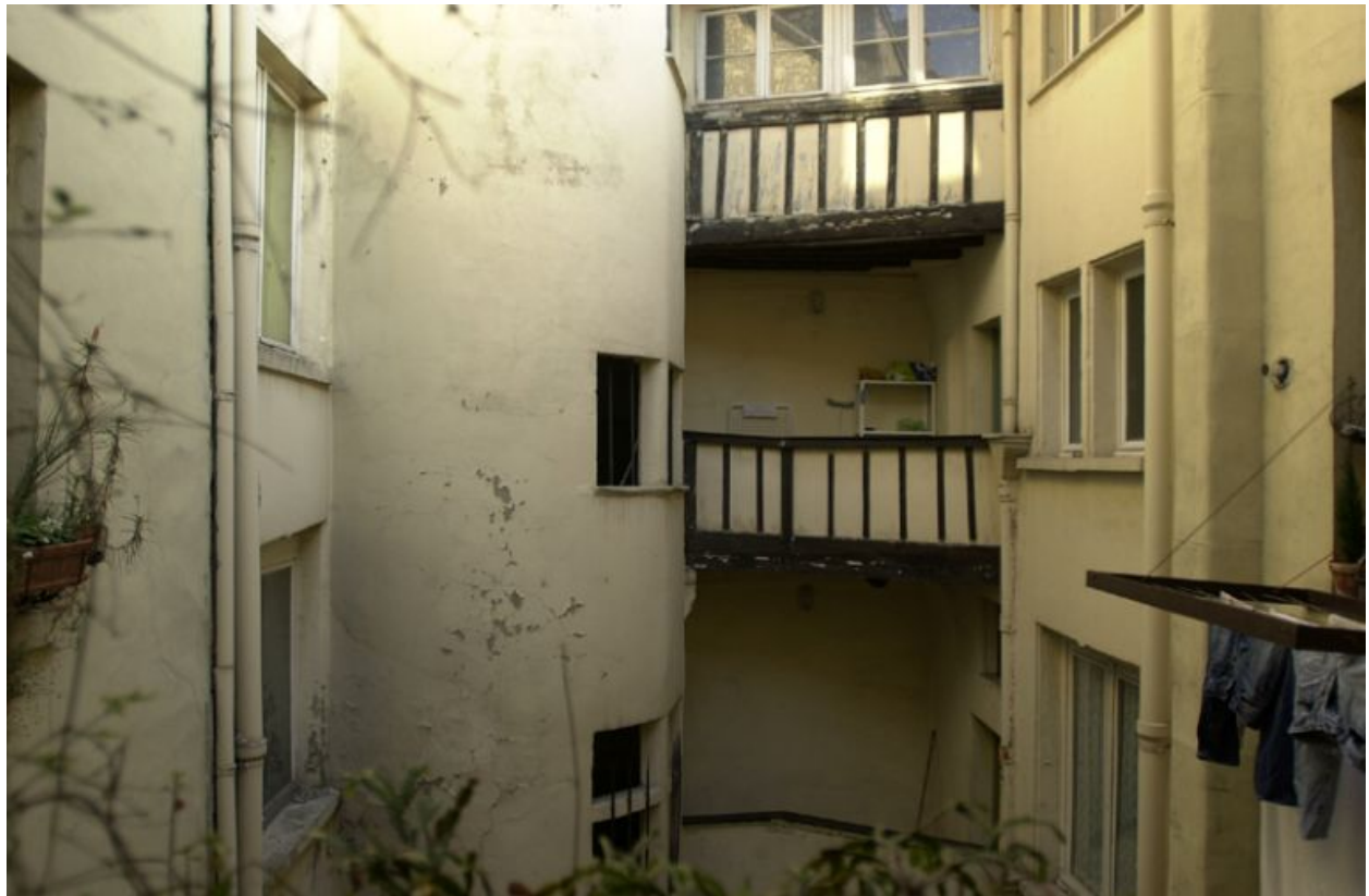
Cour, tour d'escalier et coursières des 4e et 5e étages
