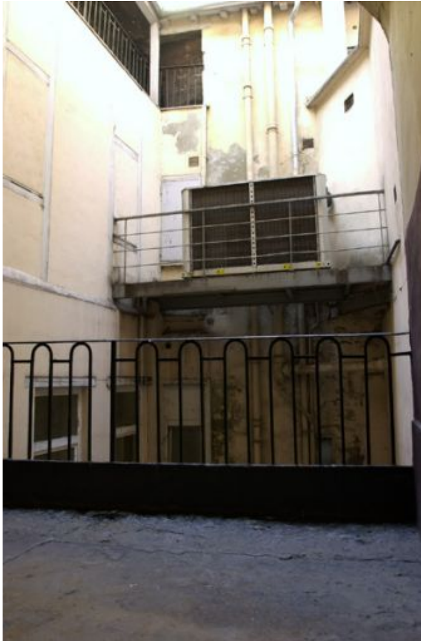
2e cour, vue prise du repos du 2e étage de l'escalier
