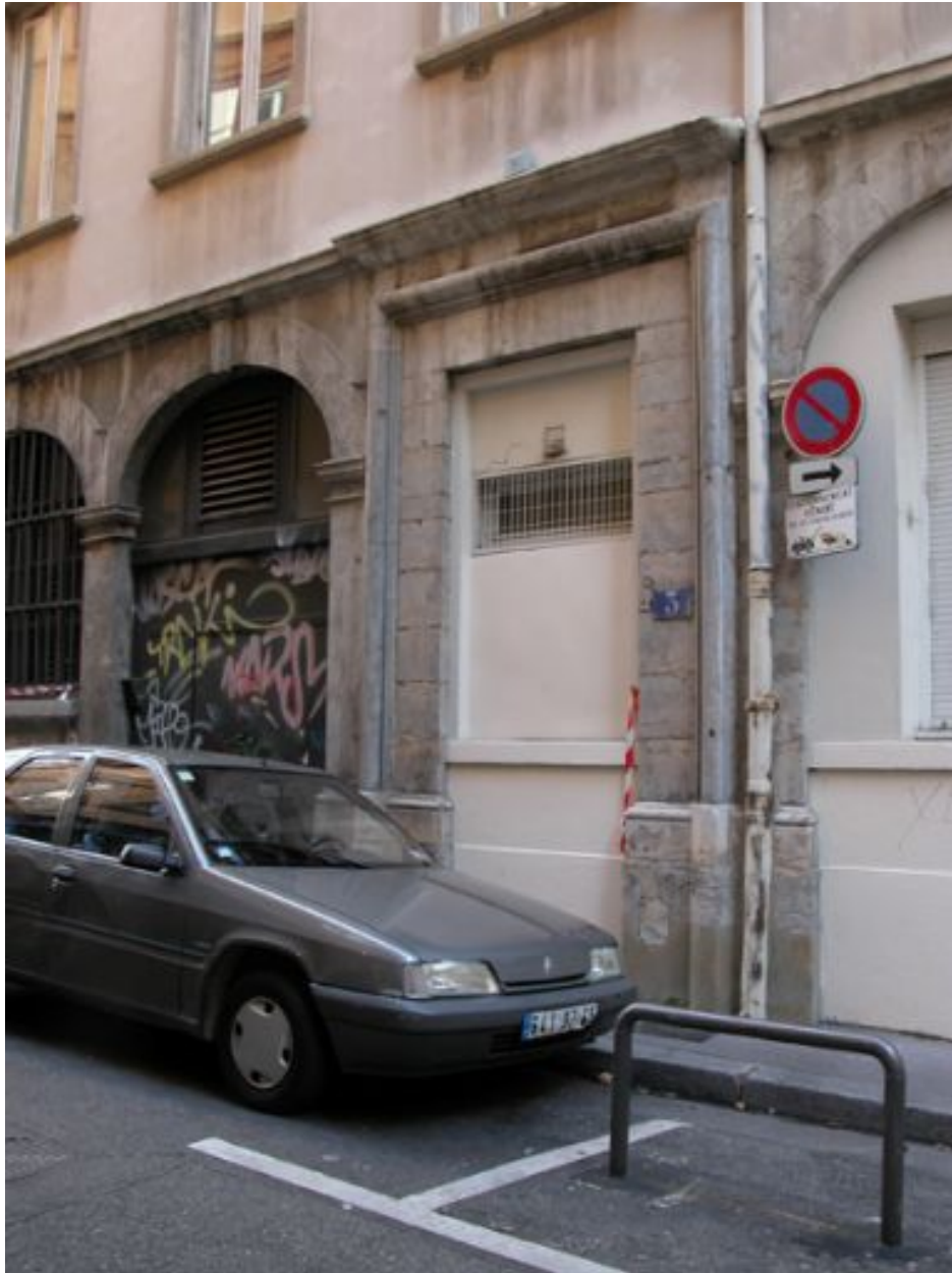
Façade rue des Forces, ancienne porte
