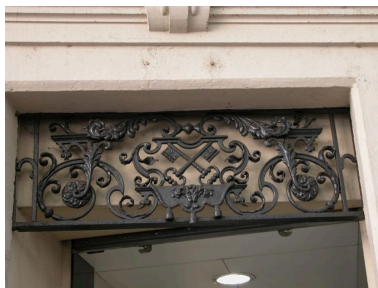
Façade place Antoine-Rivoire, ancienne porte, tympan de ferronnerie aux armes du chapitre de Saint-Nizier Phot. Bernard Ducouret IVR82_20046905828NUCA
