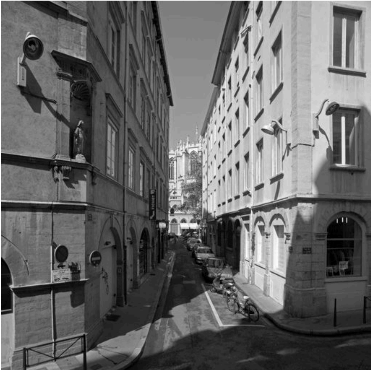
Vue générale de la façade sur la rue des Forces
