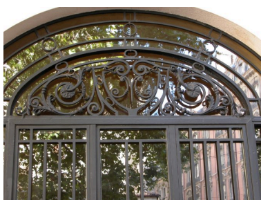
Façade place Antoine-Rivoire, nouvelle porte, détail de la ferronnerie Phot. Bernard Ducouret IVR82_20046905834NUCA
