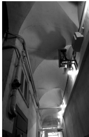
Voûte de l'allée vers la rue Gentil Phot. Bernard Ducouret IVR82_20056902030NUC
