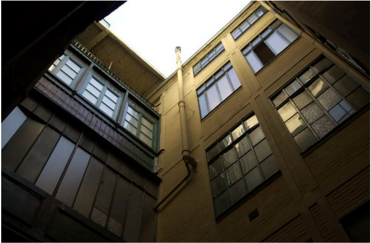
1ère cour, partie haute et coursières
