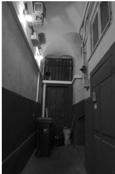
Allée vue en direction de l'ancienne entrée rue des Forces et départ du 2e escalier Phot. Bernard Ducouret IVR82_20056902031NUC
