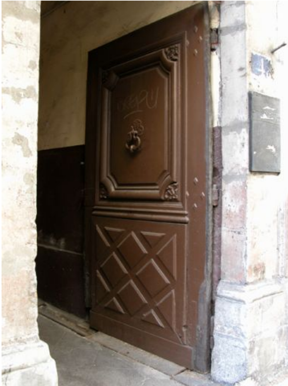
Façade rue Gentil, vantail de la porte
