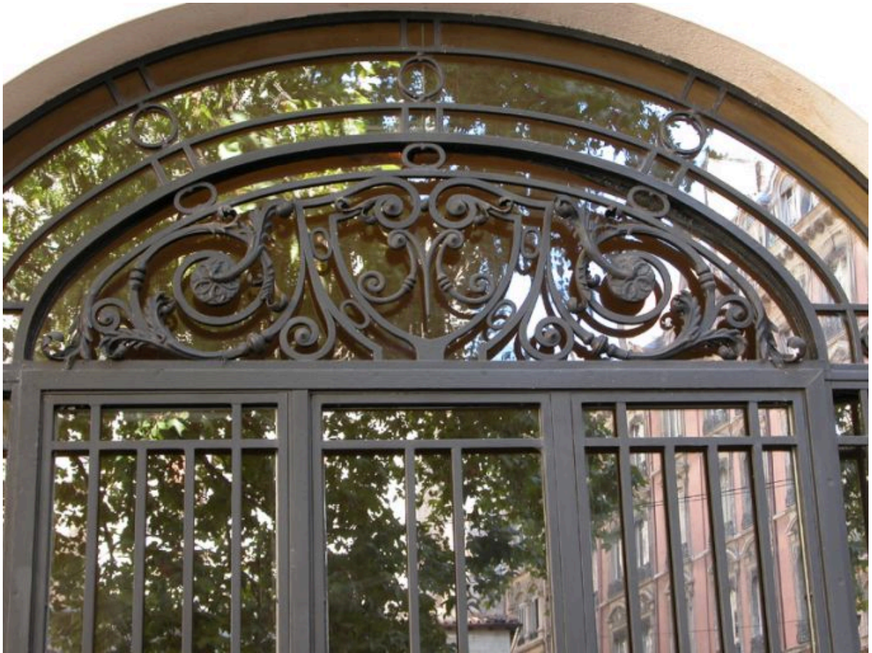
Façade place Antoine-Rivoire, nouvelle porte, détail de la ferronnerie
