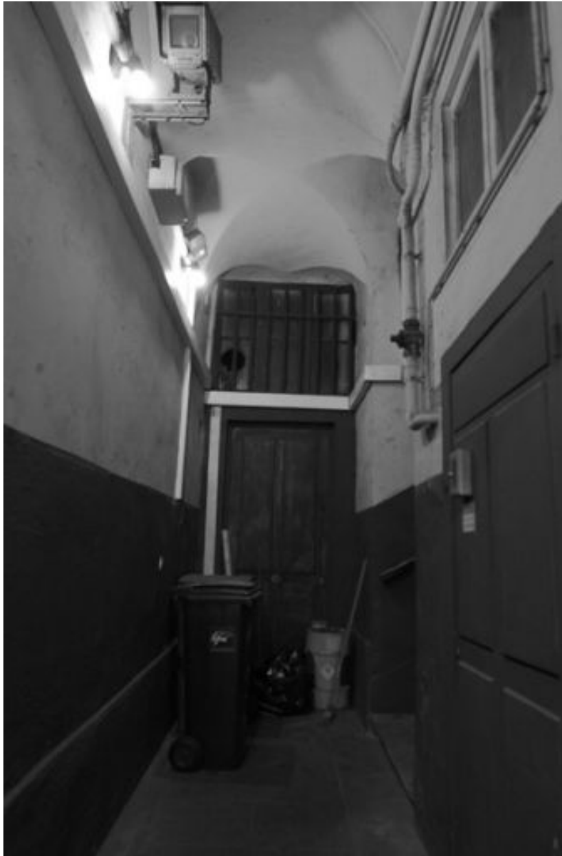
Allée vue en direction de l'ancienne entrée rue des Forces et départ du 2e escalier
