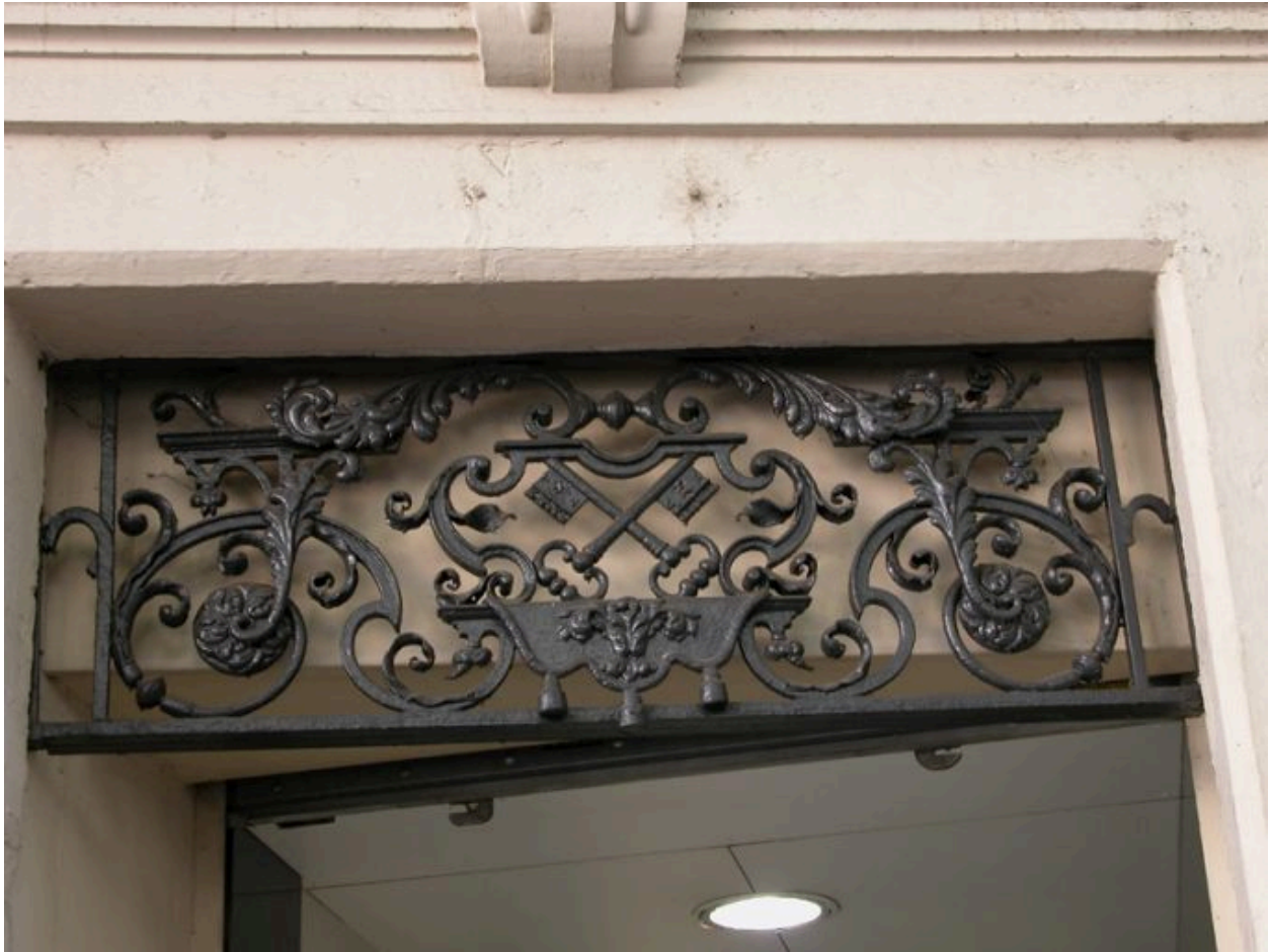
Façade place Antoine-Rivoire, ancienne porte, tympan de ferronnerie aux armes du chapitre de Saint-Nizier
