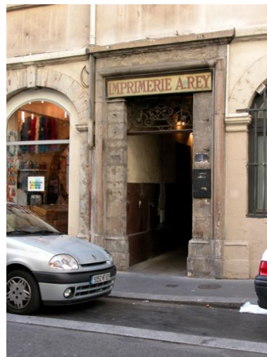
Façade rue Gentil, porte Phot. Bernard Ducouret IVR82_20046905829NUCA
