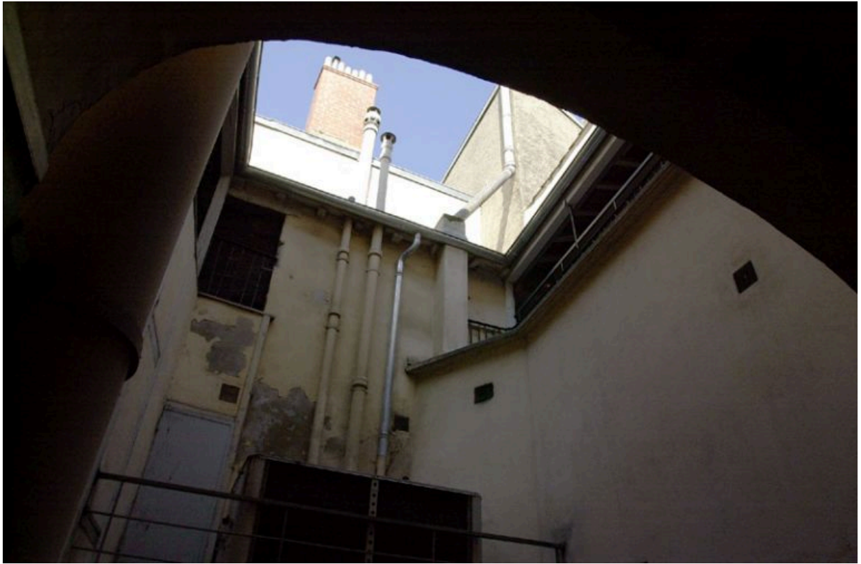
2e cour, vestiges des galeries qui la bordaient
