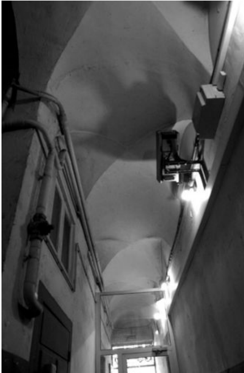
Voûte de l'allée vers la rue Gentil
