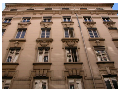
Façade rue Gentil, vue par-dessous de la partie droite Phot. Bernard Ducouret IVR82_20046905822NUCA
