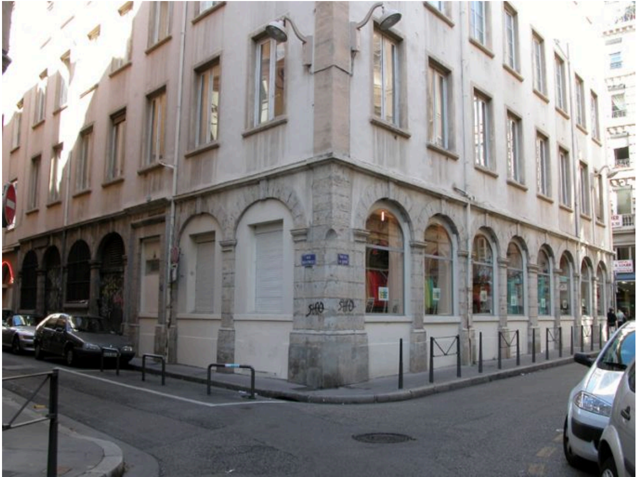
Vue générale du rez-de-chaussée et du 1er étage à l'angle des rues des Forces (à gauche) et de la Gerbe
