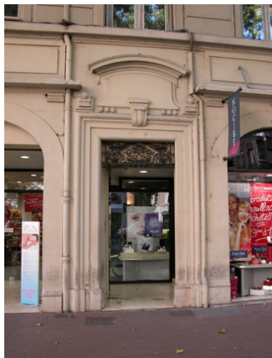
Façade place Antoine-Rivoire, ancienne porte Phot. Bernard Ducouret IVR82_20046905827NUCA
