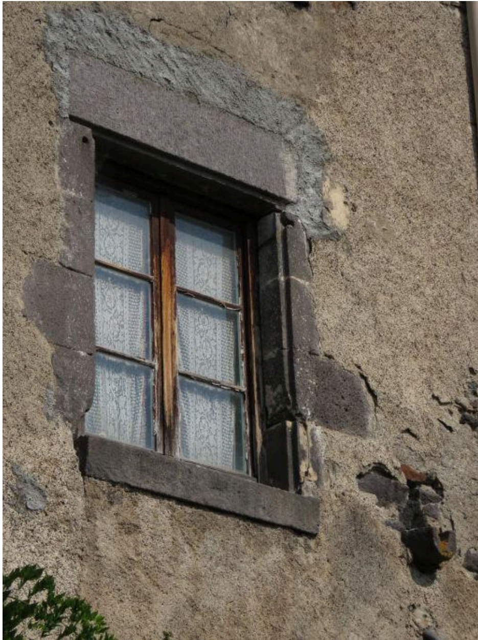
Vue de détail : encadrement de la baie du premier étage et pierre d'écoulement d'évier
