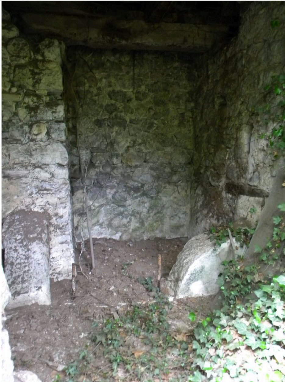
Vestige de l'ancienne dérivation sous le bâtiment secondaire.
