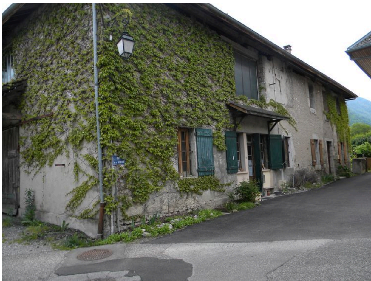
Vue de la façade principale du bâtiment principal.
