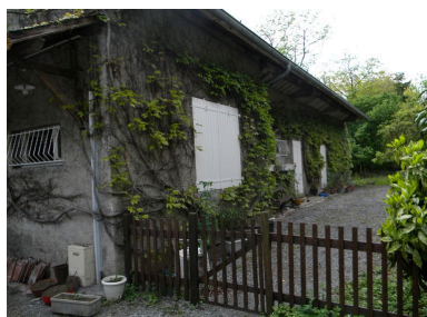
vue de la façade principale du bâtiment secondaire situé au bord de la rivière. Phot. Jérôme Daviet IVR82_20117400735NUCA
