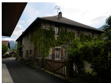
Vue générale du bâtiment principal avec les anciennes habitations attenantes Phot. Jérôme Daviet IVR82_20117400732NUCA
