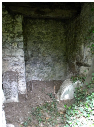
Vestige de l'ancienne dérivation sous le bâtiment secondaire. Phot. Jérôme Daviet IVR82_20117400737NUCA
