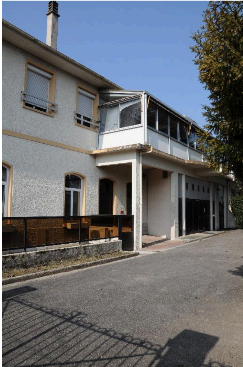
La façade principale remaniée
