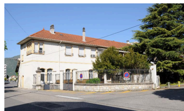
Vue d'ensemble Phot. Denys Harreau IVR82_20147300560NUCA
