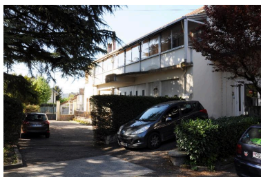
Vue de trois quart droit Phot. Denys Harreau IVR82_20147300559NUCA
