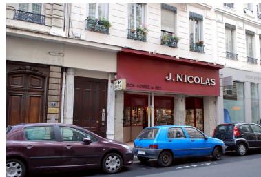
Elévation antérieure : le rez-de-chaussée Phot. Véronique Belle IVR82_20096904678NUCA
