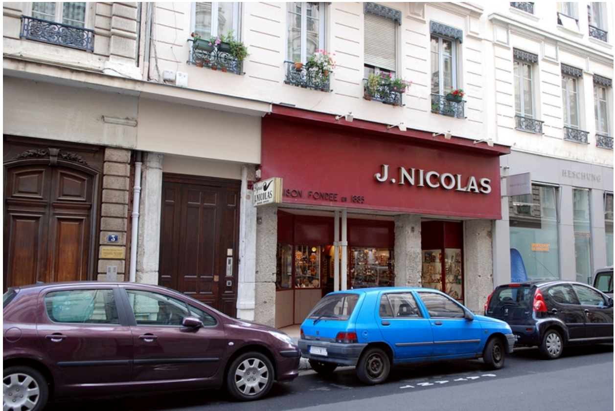
Élévation antérieure : le rez-de-chaussée
