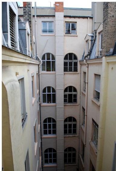
Elévation sur cour depuis l'escalier desservant l'immeuble 7 rue Gasparin Phot. Véronique Belle IVR82_20096904680NUCA
