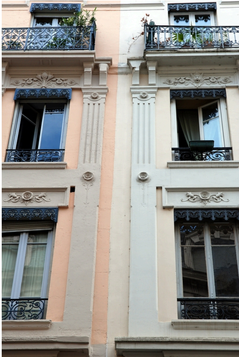
Elévation antérieure : vue partielle avec celle de l'immeuble mitoyen 7 rue Gasparin
