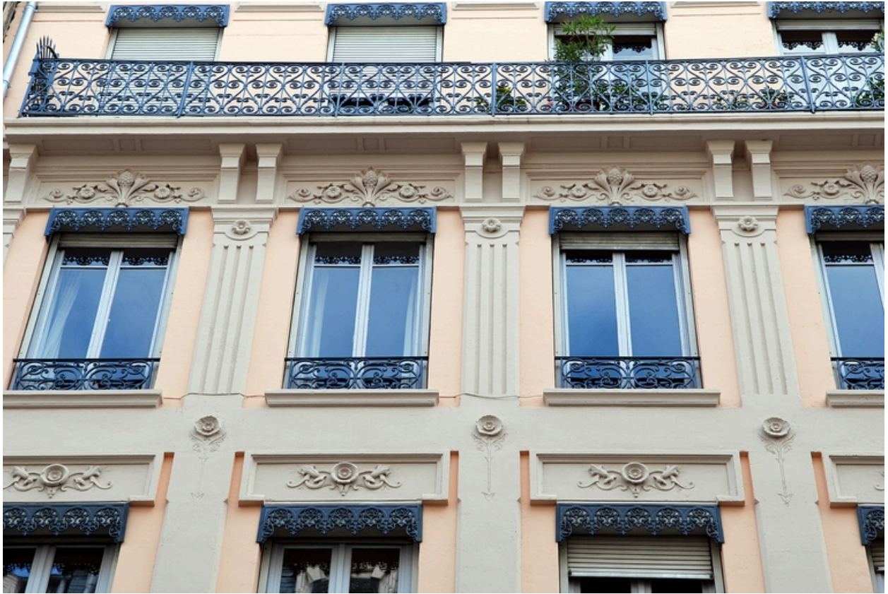
Elévation antérieure : vue partielle
