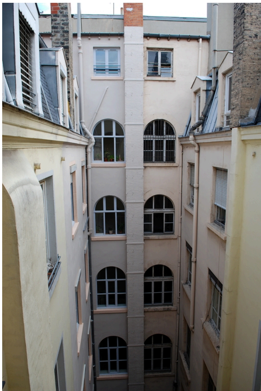
Elévation sur cour depuis l'escalier desservant l'immeuble 7 rue Gasparin
