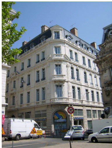
Vue d'ensemble Phot. Cendrine Sanquer IVR82_20084200524NUCA
