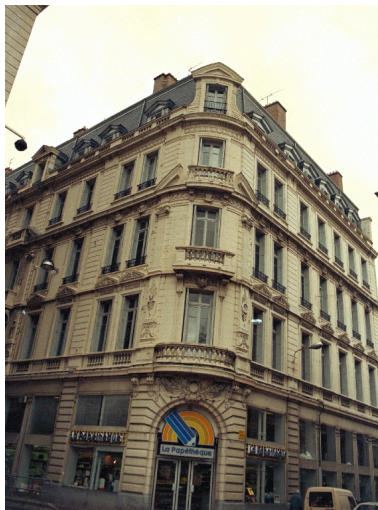
Vue d'ensemble. Etat en 1996 Phot. Cendrine Sanquer IVR82_19974202065ZE
