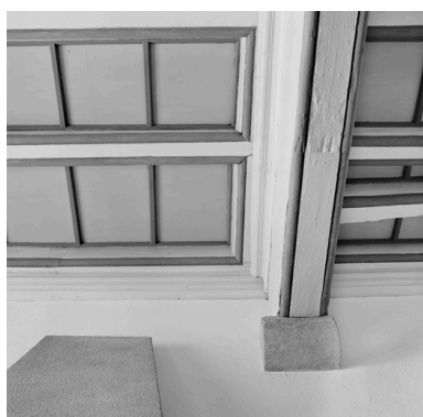
Vue partielle du plafond à caissons du 1er étage. Phot. Didier Gourbin IVR82_20064200961X
