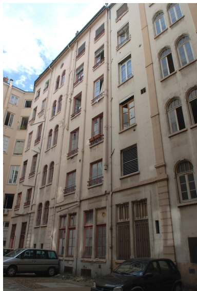
Elévation sur cour Phot. Véronique Belle IVR82_20096904970NUCA
