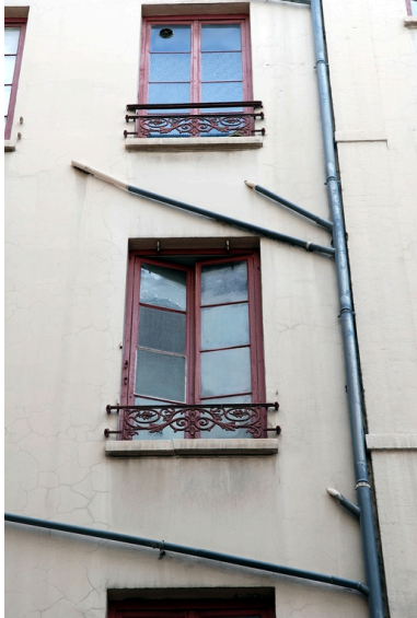
Elévation sur cour : garde-corps Phot. Véronique Belle IVR82_20096904973NUCA
