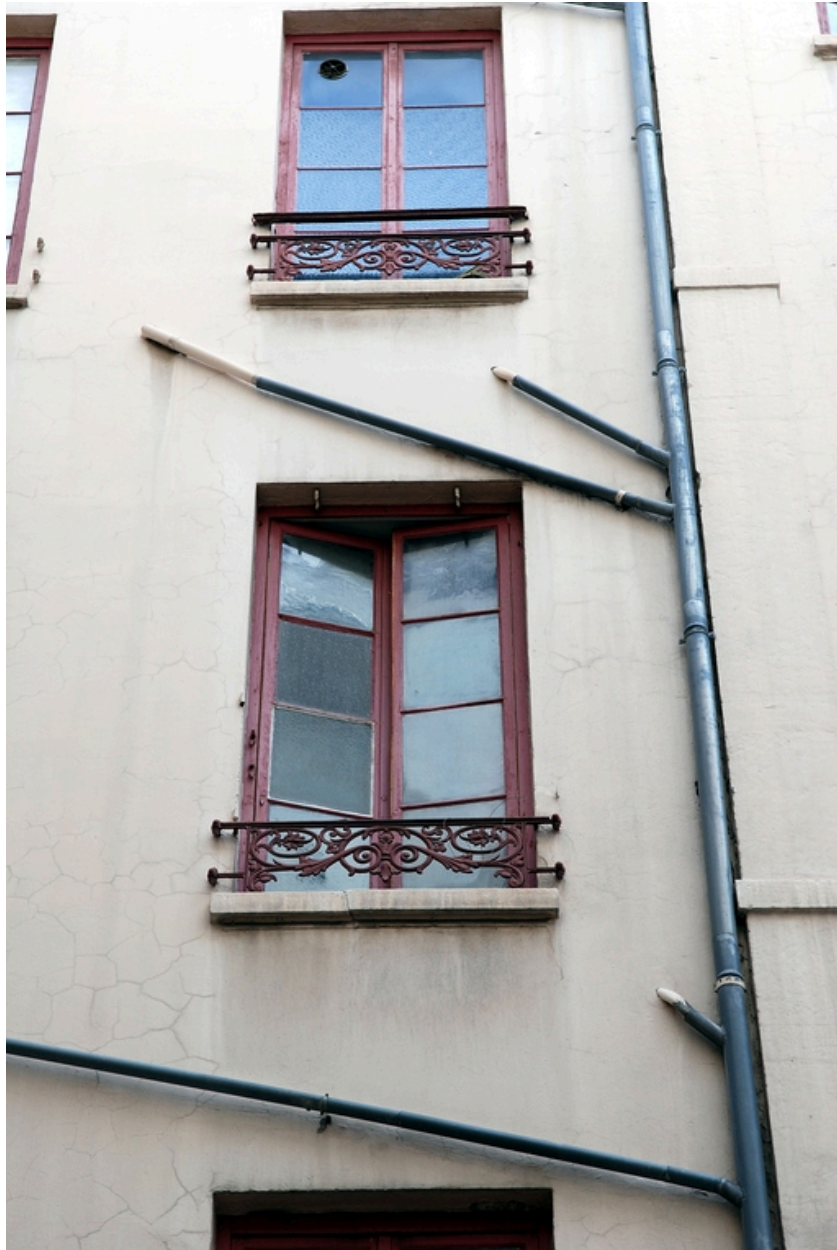
Elévation sur cour : garde-corps
