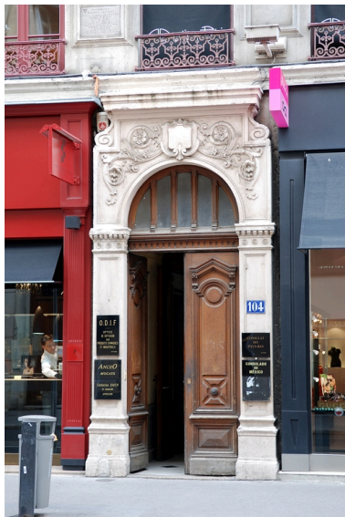
Elévation antérieure : la porte Phot. Véronique Belle IVR82_20096904968NUCA
