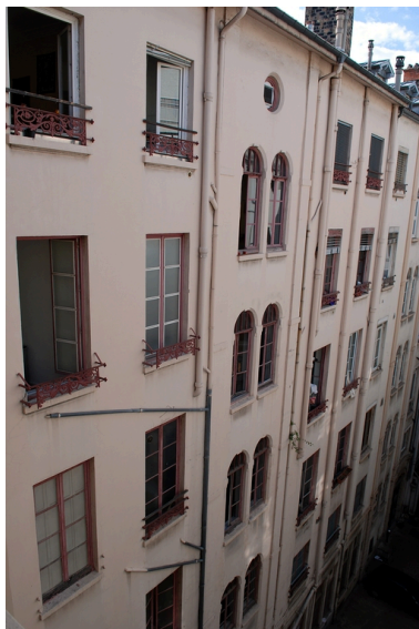
Elévation sur cour : vue partielle depuis l'escalier 4 rue Simon-Maupin Phot. Véronique Belle IVR82_20096904971NUCA
