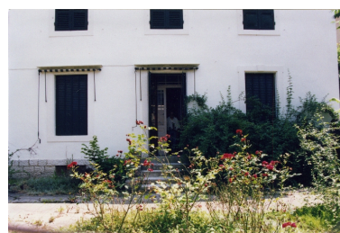
Partie basse de la façade principale Repro. François Fouger IVR82_20127300873NUCB
