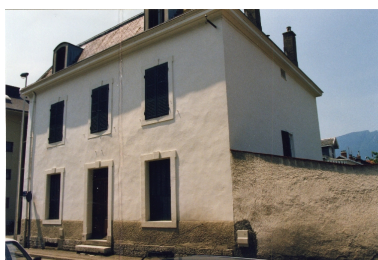
Vue d'ensemble Repro. François Fouger IVR82_20127300869NUCB
