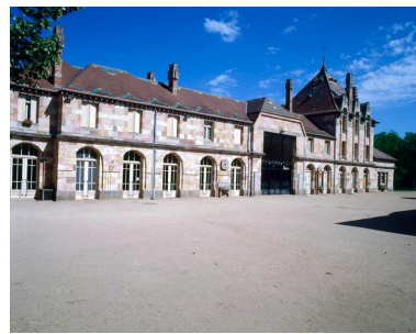
L'ancienne gare de Nérís-les-Bains en 1997 depuis l'emplacement des voies, côté ouest, avant réaménagement du bâtiment en centre socio-culturel.
