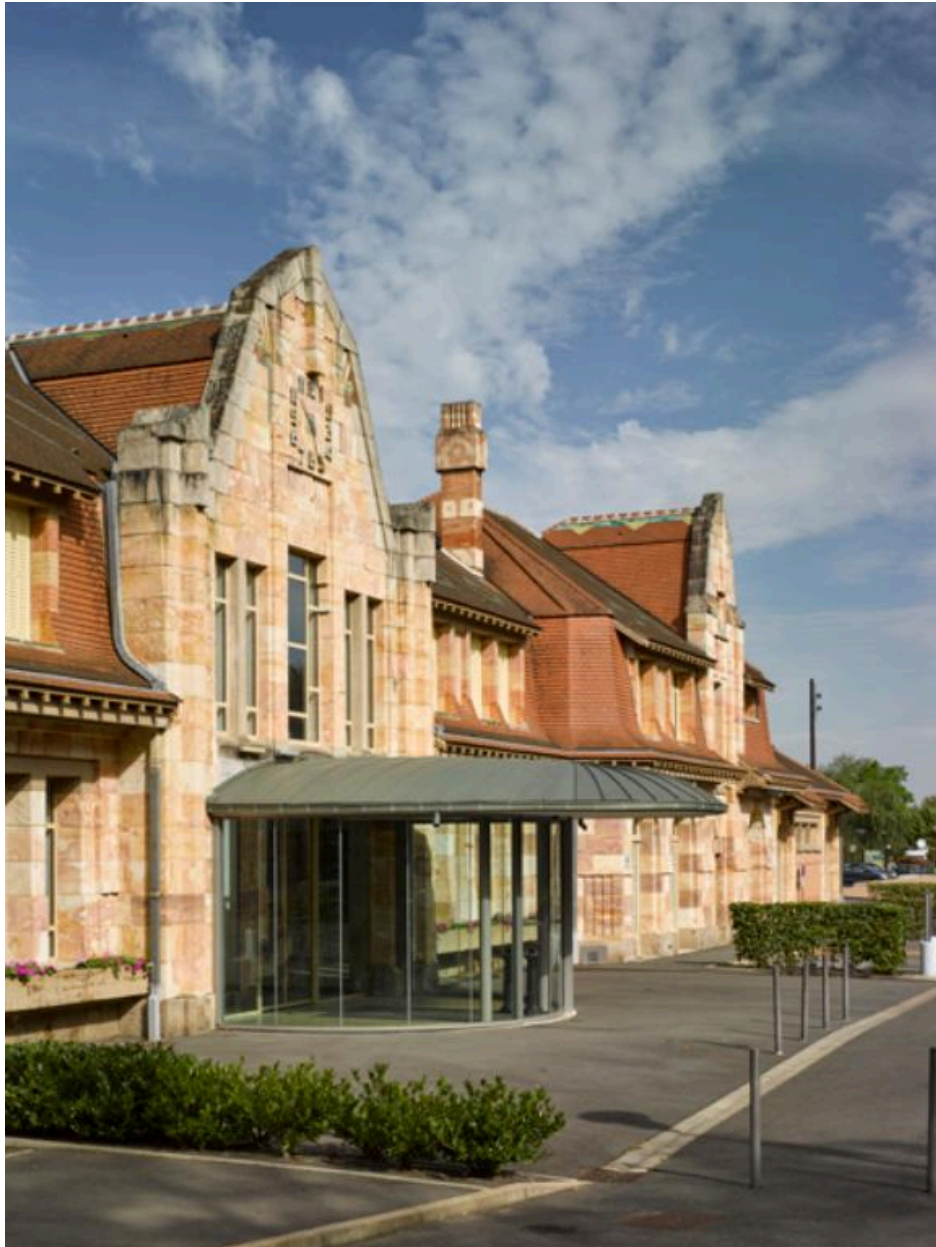
Détail de la façade est de la gare de Nérís (après réaménagement en centre socio-culturel), du côté de l'ancienne cour des voyageurs.
