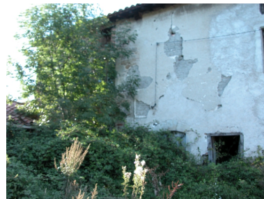
Vue du logis : porte d'entrée en arc segmentaire. Phot. Thierry Monnet IVR82_20134202893NUCA
