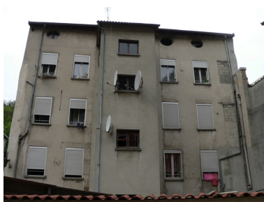
Façade arrière Phot. Isabelle Dupuis IVR82_20093800492NUCA
