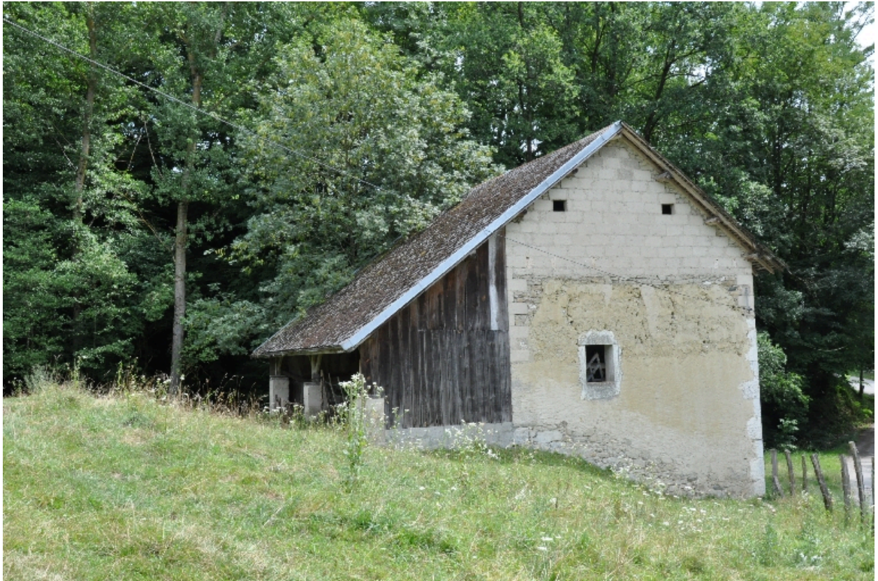
Vue amont du moulin, façades ouest et nord
