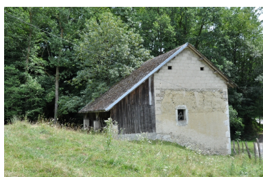
Vue amont du moulin, façades ouest et nord Phot. Yannick Milleret IVR82_20117302110NUCA
