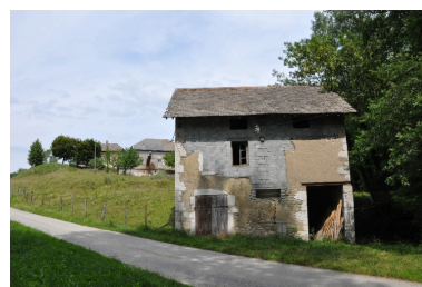
Vue générale de l'ancien moulin, façade sud Phot. Yannick Milleret IVR82_20117302109NUCA
