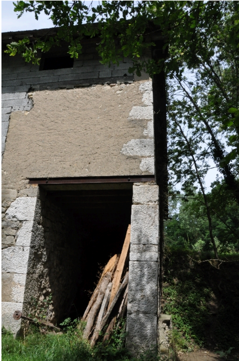
Détail de la façade sud et du mur sur où se trouvait la roue
