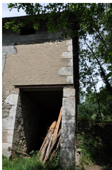
Détail de la façade sud et du mur sur où se trouvait la roue Phot. Yannick Milleret IVR82_20117302111NUCA
