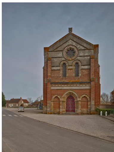
Vue de la façade occidentale Phot. Christian Parisey IVR84_20250300362NUC4A
