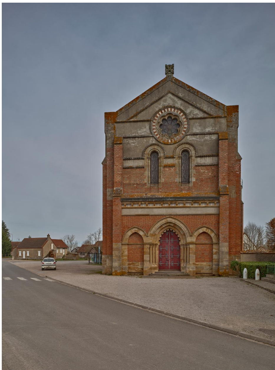
Vue de la façade occidentale
