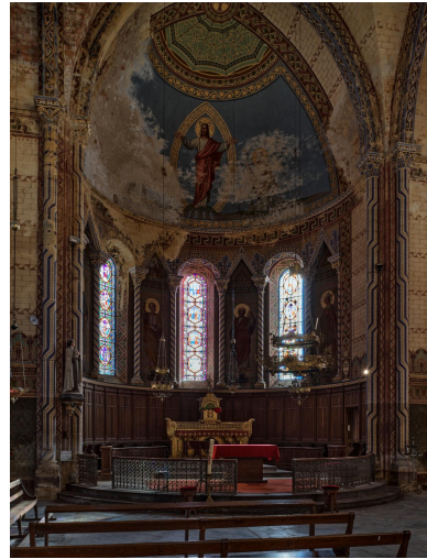
Vue du chœur Phot. Christian Parisey IVR84_20250300252NUC4A
