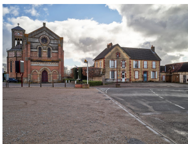
Vue de la façade occidentale Phot. Christian Parisey IVR84_20250300239NUC4A
