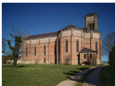
Vue du chevet et de la façade sud Phot. Christian Parisey IVR84_20250300354NUC4A
