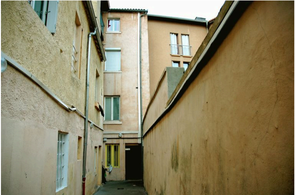
Façade est vue depuis la cour
