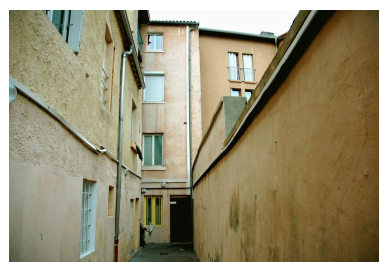
Façade est vue depuis la cour Phot. Maryannick Chalabi IVR82_20066901337NUCA
