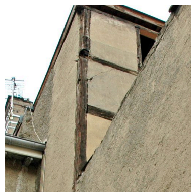
Construction en pisé et pans de bois des étages supérieures de la cage d'escalier vue depuis la cour mitoyenne au nord.
