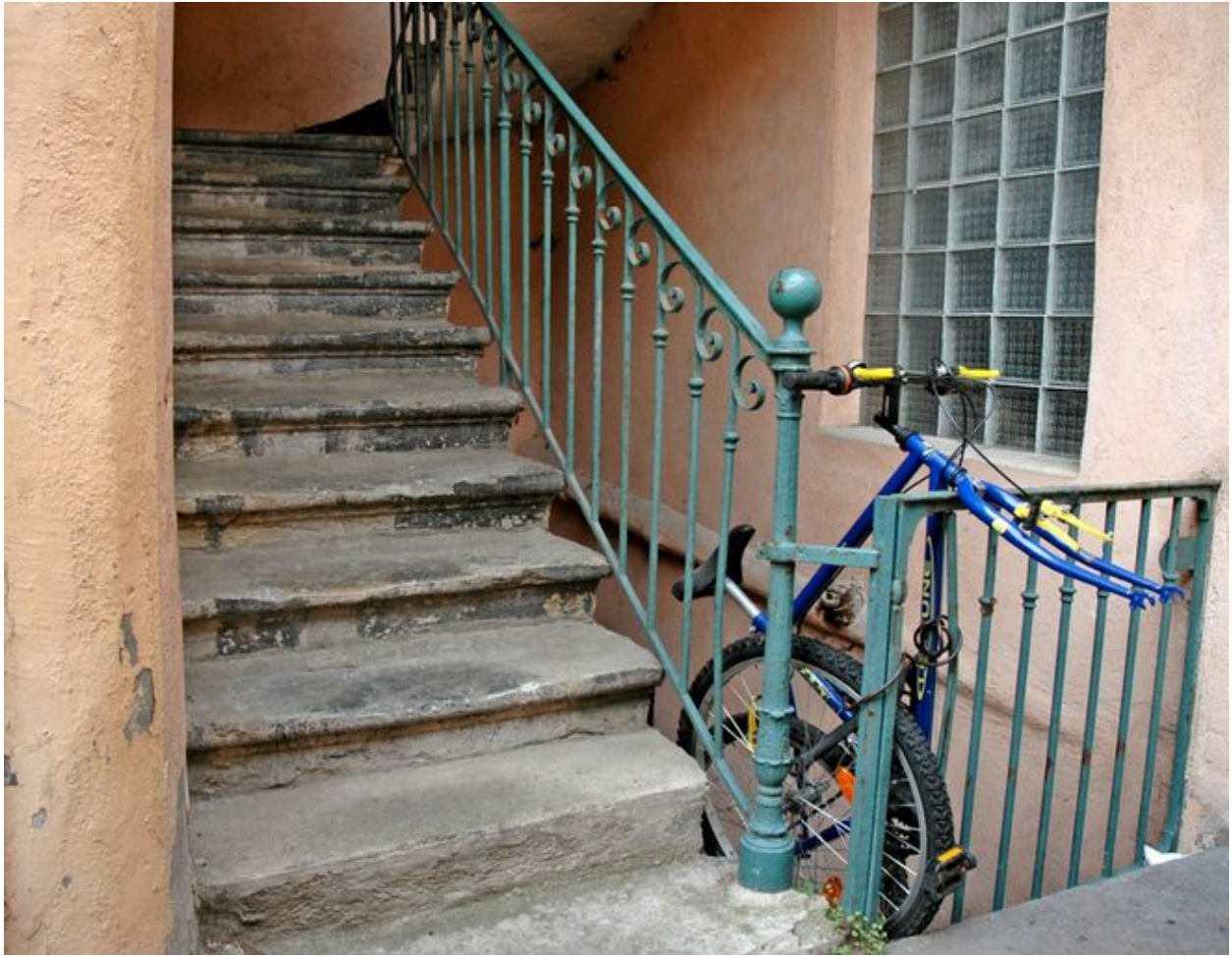
Première volée de l'escalier et portillon introduisant l'accès à la cave.
