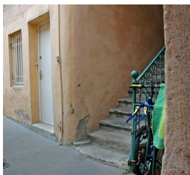
Liaison entre la cage d'escalier et l'immeuble sur cour Phot. Maryannick Chalabi IVR82_20066901339NUCA
