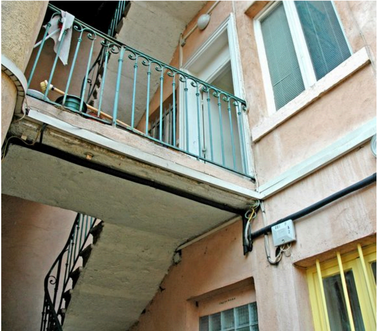
Repos du premier étage vue depuis le niveau de sol de la cour
