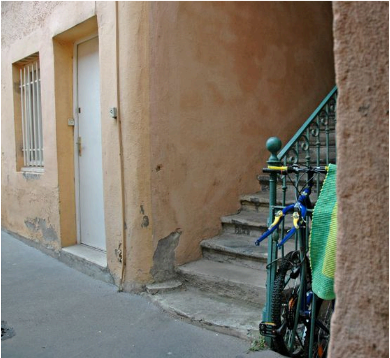
Liaison entre la cage d'escalier et l'immeuble sur cour
