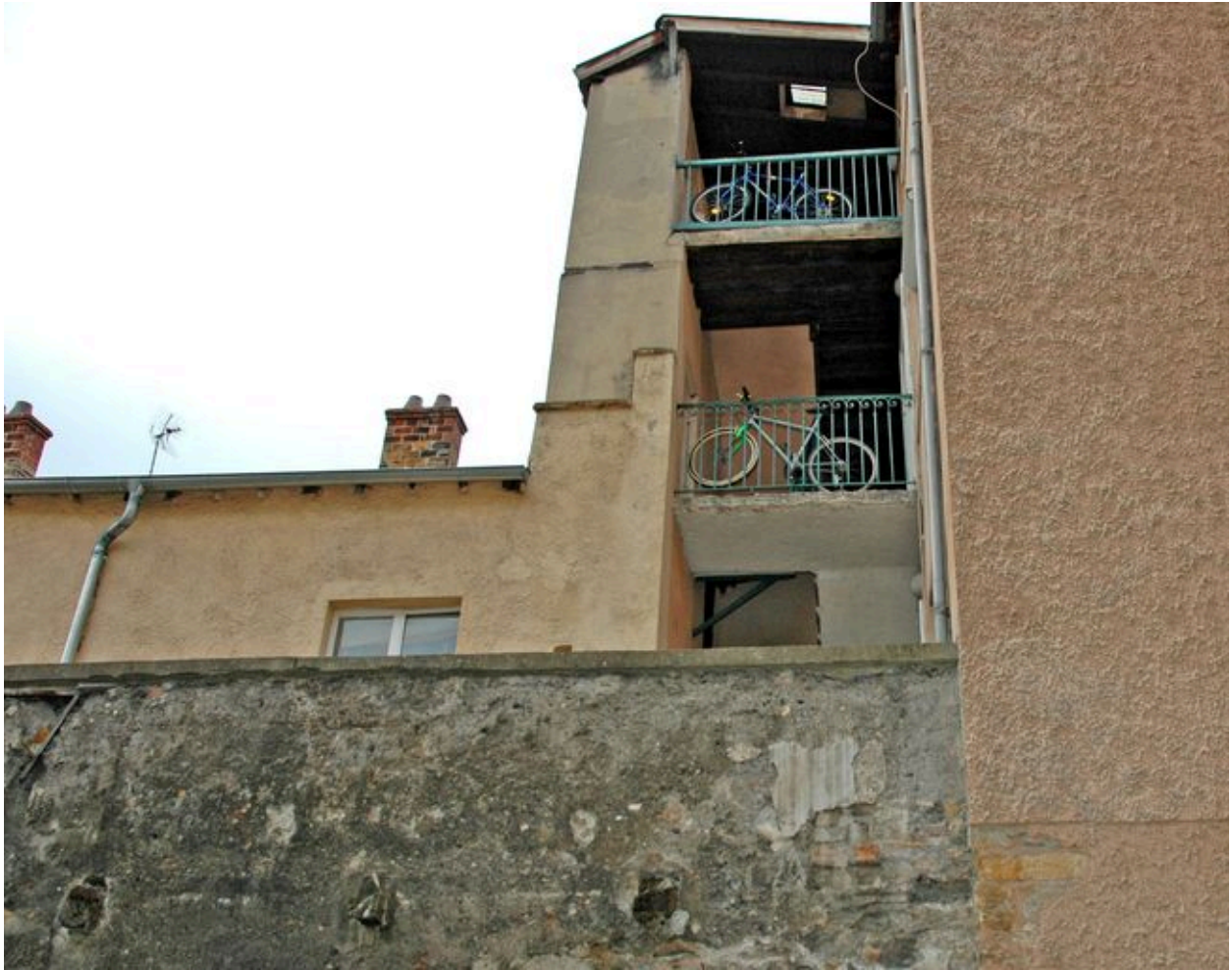
Repos du premier et du second étage vue depuis la cour mitoyenne au nord.
