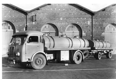
S.O.M.U.A. - JL17 - camion citerne - 1954 (Fondation Berliet) Phot. Alice Giacobelli IVR84_20226900063NUC
