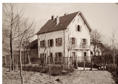
Vue générale depuis le nord-ouest, 1901 Repro. Denys Harreau IVR82_20137301110NUCB
