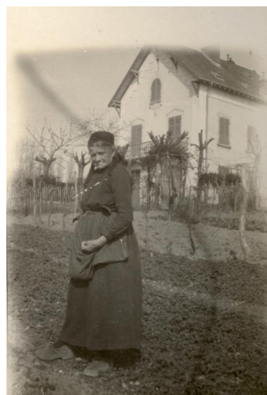
Vue prise depuis le sud-ouest, 1926 Repro. Denys Harreau IVR82_20147300108NUCB
