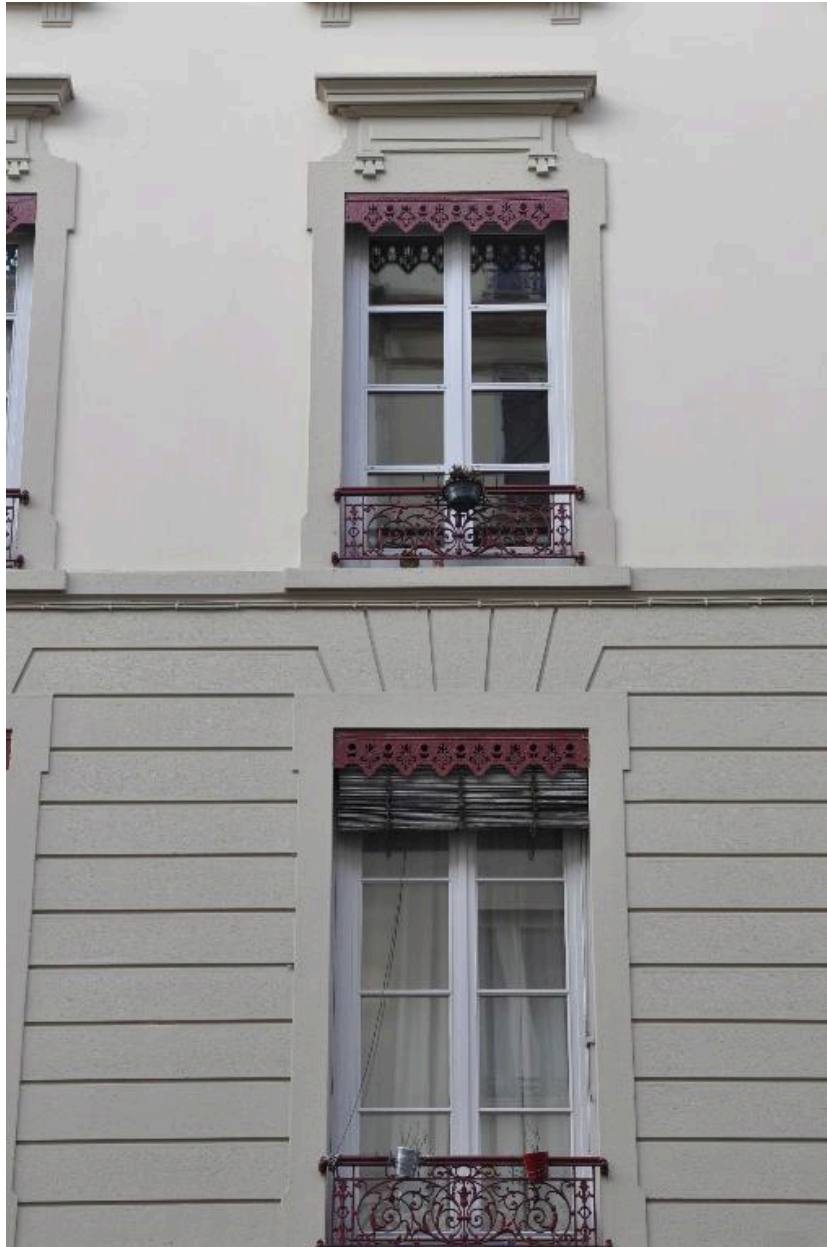
Vue rapprochée de l'élévation sur rue : décor des baies du premier et deuxième étages carrés
