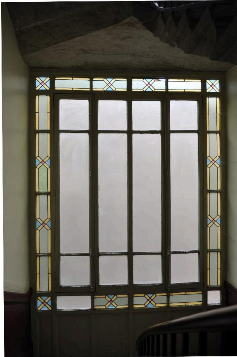
Vue intérieure : la verrière du deuxième repos de l'escalier
