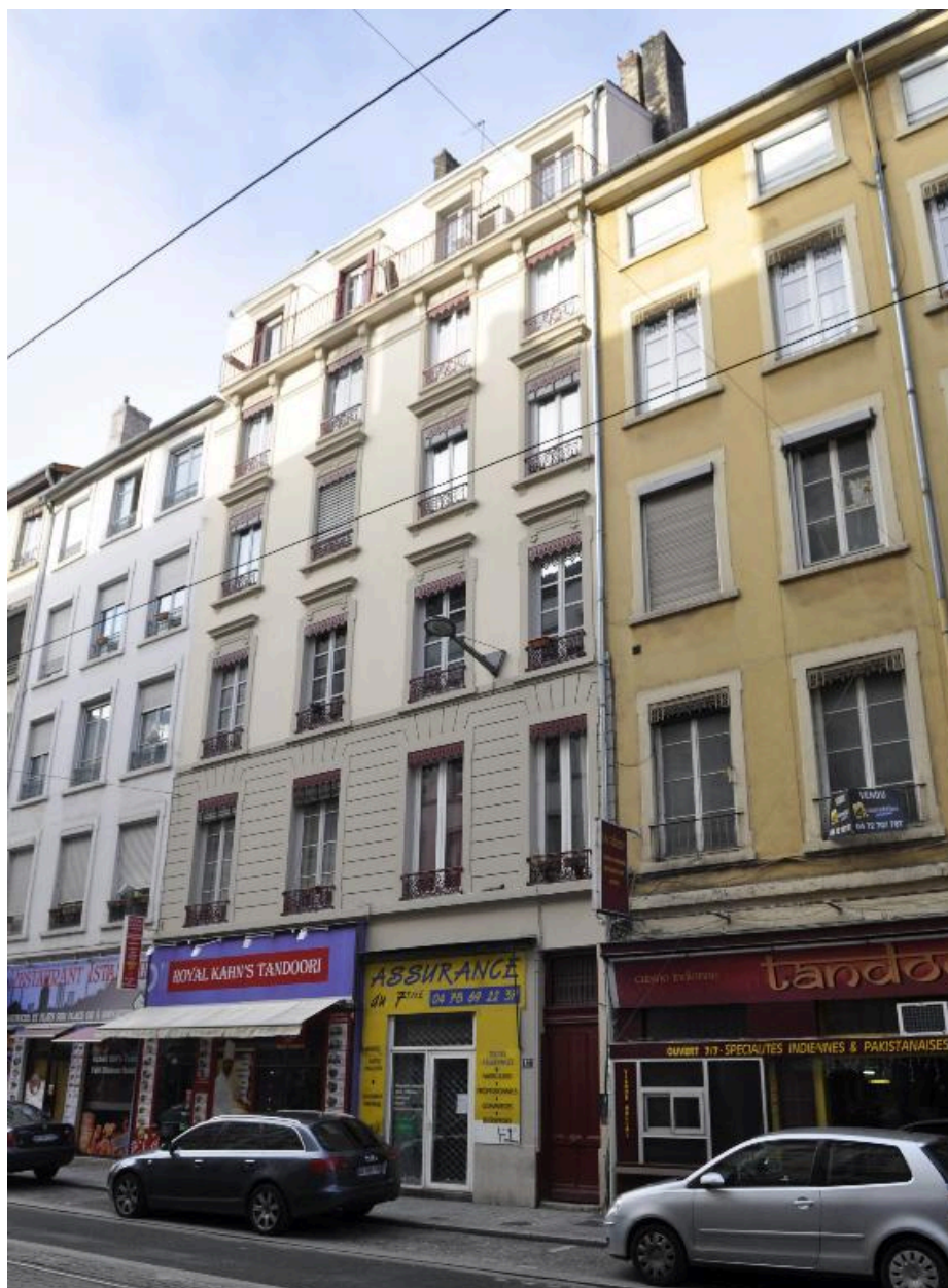
Vue générale de l'élévation sur rue
