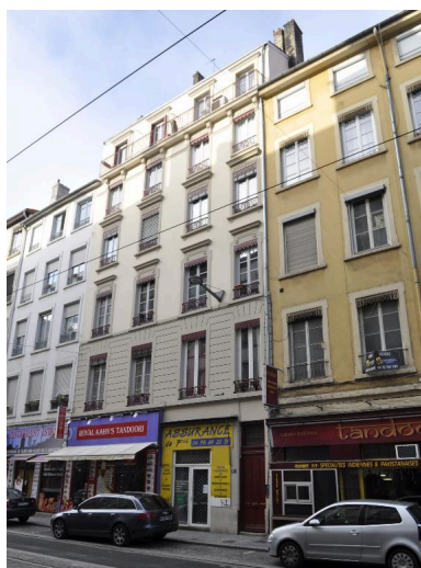
Vue générale de l'élévation sur rue Phot. Magali Delavenne IVR82_20156902741NUCA
