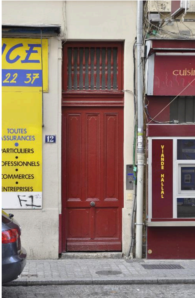
Vue rapprochée de la porte piétonne dotée d'une imposte à balustres de bois
