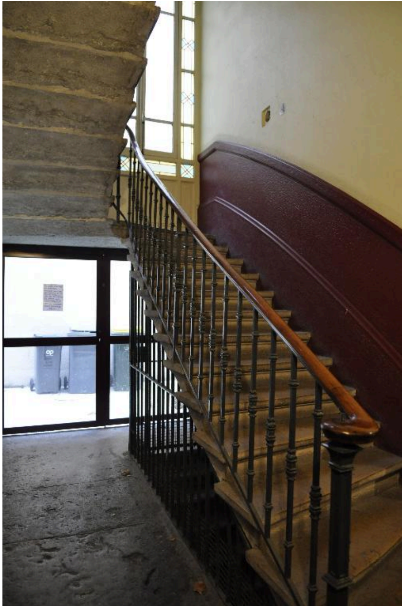
Vue intérieure : le départ de l'escalier, le sol dallé de la cage et l'accès à la cour
