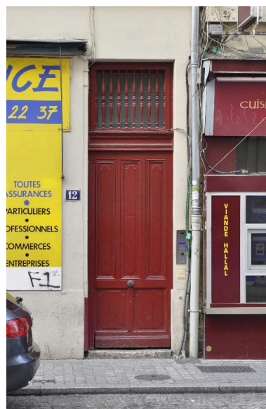
Vue rapprochée de la porte piétonne dotée d'une imposte à balustres de bois Phot. Magali Delavenne IVR82_20156902743NUCA
