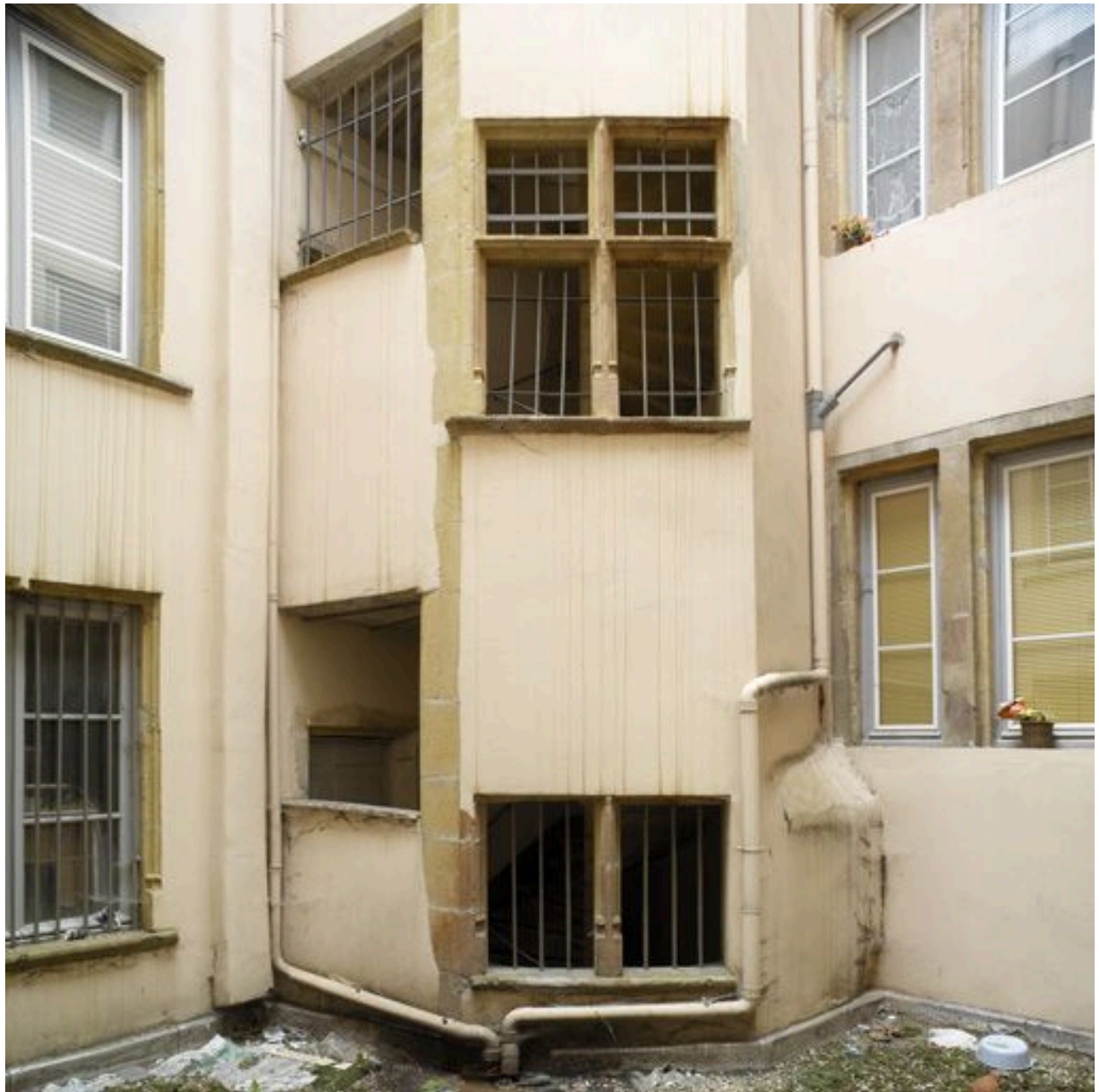
Cour, tour d'escalier, élévation à hauteur du 1er étage
