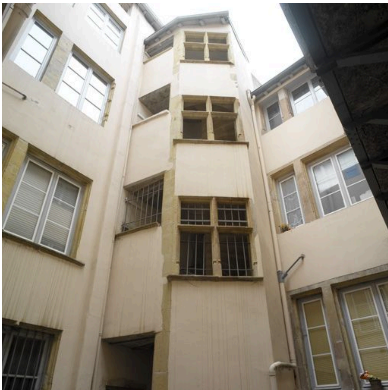
Cour, tour d'escalier, vue générale depuis le 1er étage
