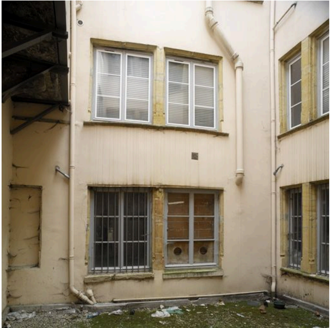
Cour, corps mince ouest, élévation des niveaux 2 et 3
