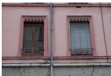
Vue rapprochée : fenêtres du premier étage Phot. Magali Delavenne IVR84_20166902417NUCA
