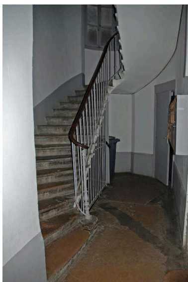
Vue intérieure : le départ de l'escalier Phot. Magali Delavenne IVR84_20166902418NUCA
