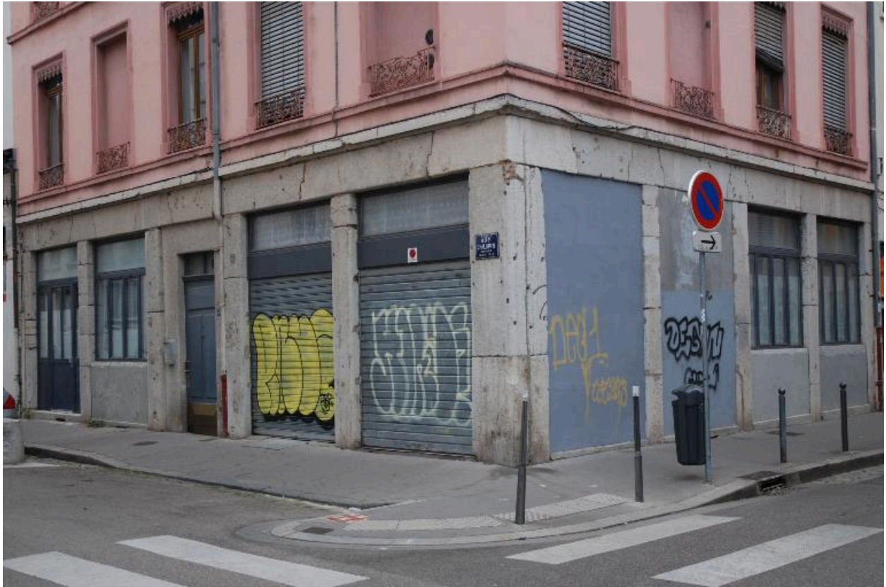
Vue du rez-de-chaussée
