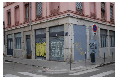
Vue du rez-de-chaussée Phot. Magali Delavenne IVR84_20166902416NUCA
