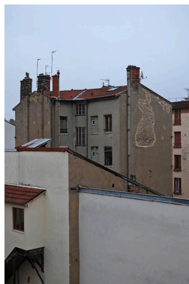
Vue d'ensemble, depuis l'arrière Phot. Magali Delavenne IVR84_20166902419NUCA
