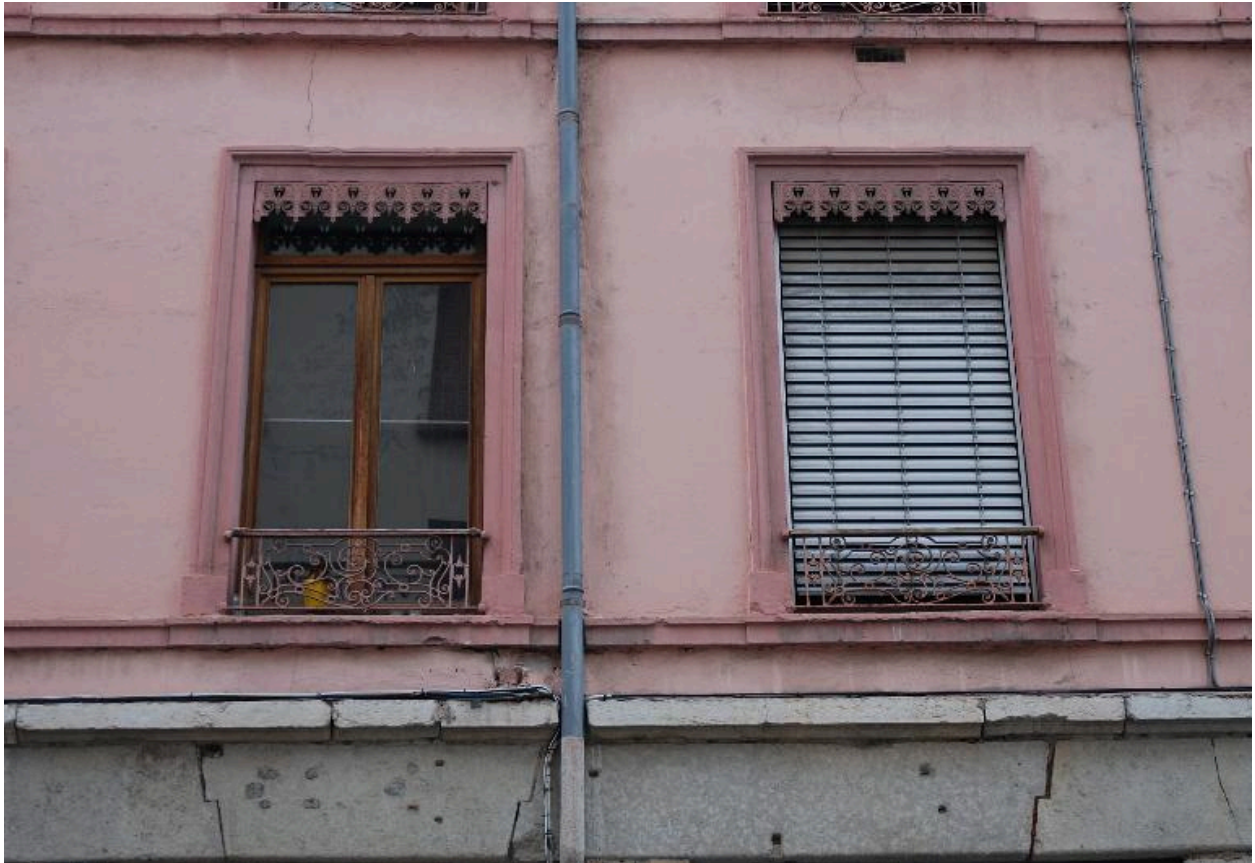
Vue rapprochée : fenêtres du premier étage
