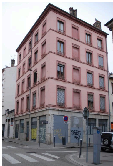
Vue générale, depuis le nord Phot. Magali Delavenne IVR84_20166902300NUCA
