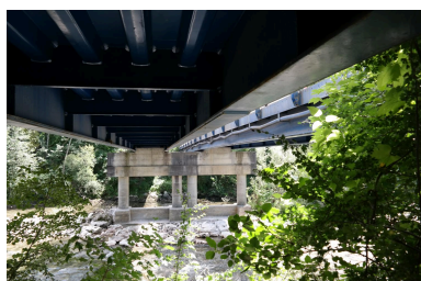
Pont des Îles, détail de la pile et tablier vue de dessous Phot. Pascale Renard IVR84_20207403883NUCA
