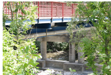
Pont des Îles, détail du tablier et des garde-corps Phot. Pascale Renard IVR84_20207403882NUCA
