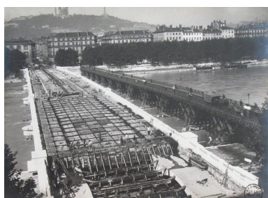
[Construction du Pont de l'Hôtel-Dieu sur le Rhône] / F. Pacalet, Ch. Volatier, Rapidphoto phot., [ca 1918]. 1 fotogr. : n. et b. (AM Lyon. 2 Ph 00283, n°12). La passerelle provisoire et le pont Wilson Phot. F. Bardoneschi, Autr. Pacalet (photographe), Autr. Volatier (photographe) IVR82_20106902775NUCAB
