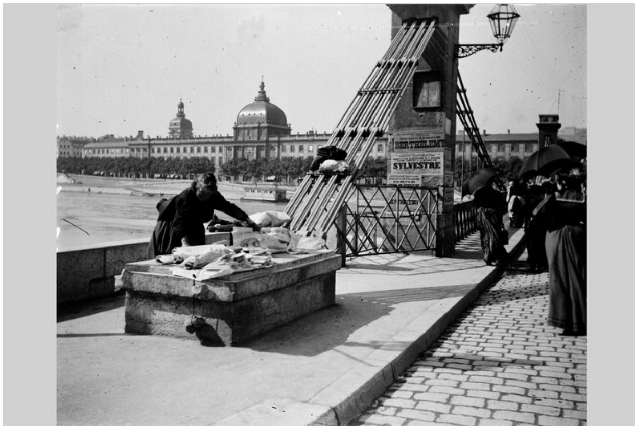
[Pont de l'Hôtel-Dieu, détail]. [1er quart du 20e siècle]. 1 fotogr. : n. et b. (AM Lyon. 10 Ph 148)
