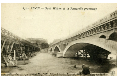
5702. Lyon - Pont Wilson et la Passerelle provisoire / S. Farges édit. Lyon : Farges, [ca 1918]. 1 impr. photoméc. (carte postale) : n. et b. (MdFR. Collection Rondeau, CP RON 0631) Phot. Maison du Fleuve Rhône, Autr. auteur inconnu 1_ IVR82_20106902776NUCAB
