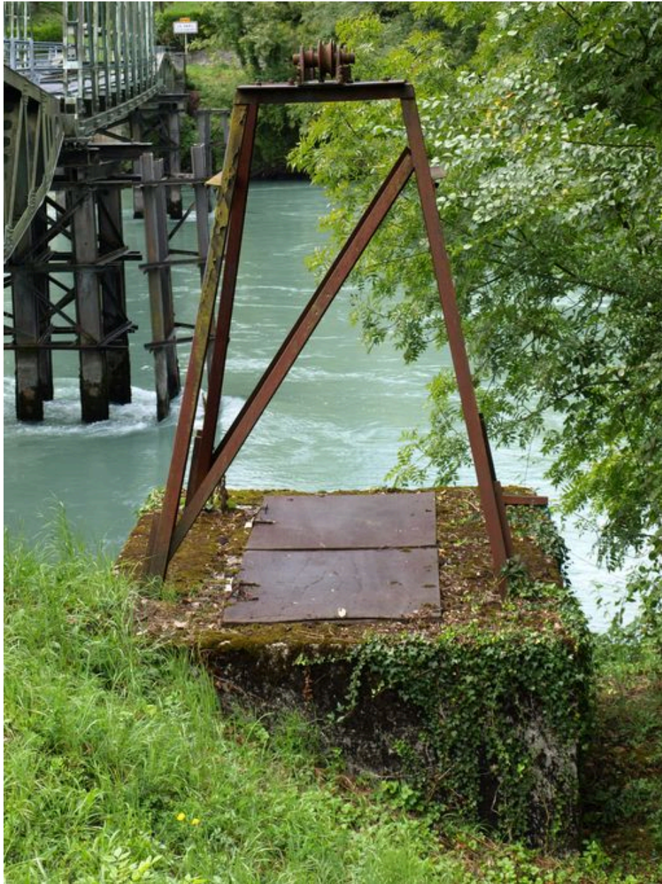
Treuil, vue partielle (rive gauche)
