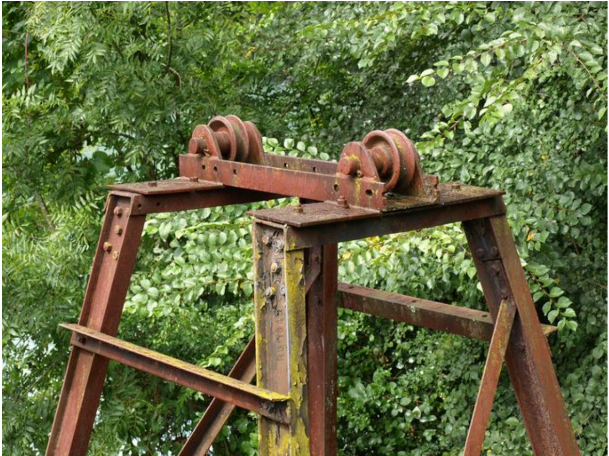
Treuil, vue partielle : poulie
