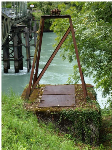
Treuil, vue partielle (rive gauche) Phot. B. Decrock IVR82_20100100155NUCA
