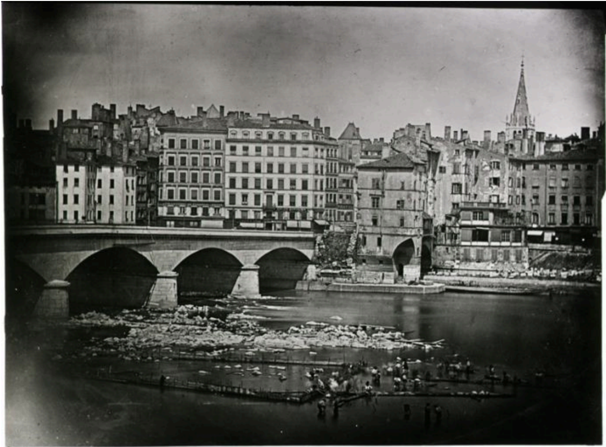
Démolition du Pont du Change, fotogr., ca 1846-1847
