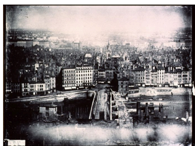
Démolition du pont de Pierre, pont de Nemours terminé, fotogr., ca 1846 Phot. Repro. BM Lyon D. Nicolle IVR82_20056902070NUCB
