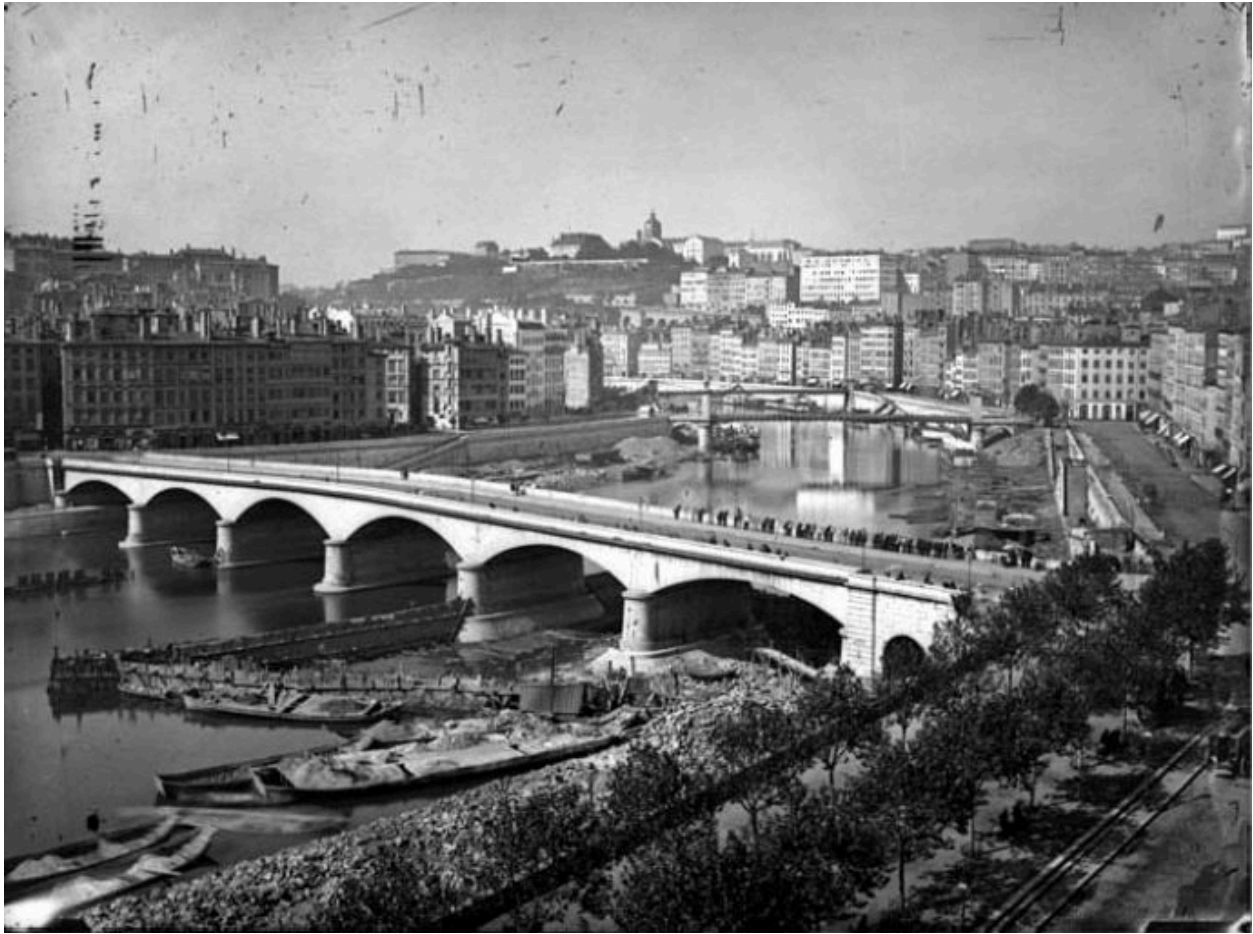
Pont du Change lors du dérochement du lit de la Saône, vers 1862
