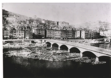
Après la démolition du pont du Change, fotogr., ca 1846-1847 Phot. Repro. BM Lyon D. Nicolle IVR82_20056902060NUCB
