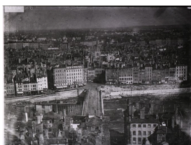
Démolition du Pont de Pierre [achèvement], fotogr., ca 1848 Phot. Repro. BM Lyon D. Nicolle IVR82_20056902066NUCB
