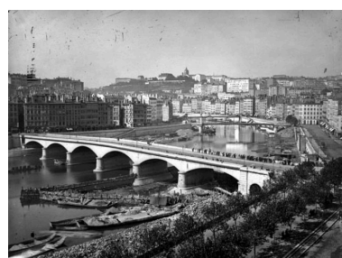
Pont du Change lors du dérochement du lit de la Saône, vers 1862 Phot. Phot. AM Lyon IVR82_20056900447NUCB
