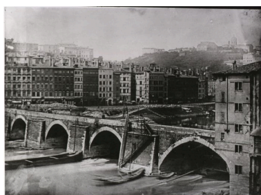
Le Pont de Pierre lors de la construction du nouveau pont, 1844-1845 Phot. Repro. BM Lyon D. Nicolle IVR82_20056902056NUCB
