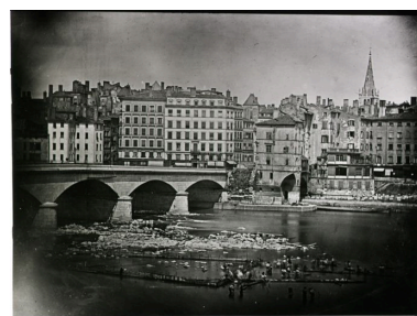
Démolition du Pont du Change, fotogr., ca 1846-1847 Phot. Repro. BM Lyon D. Nicolle IVR82_20056902061NUCB
