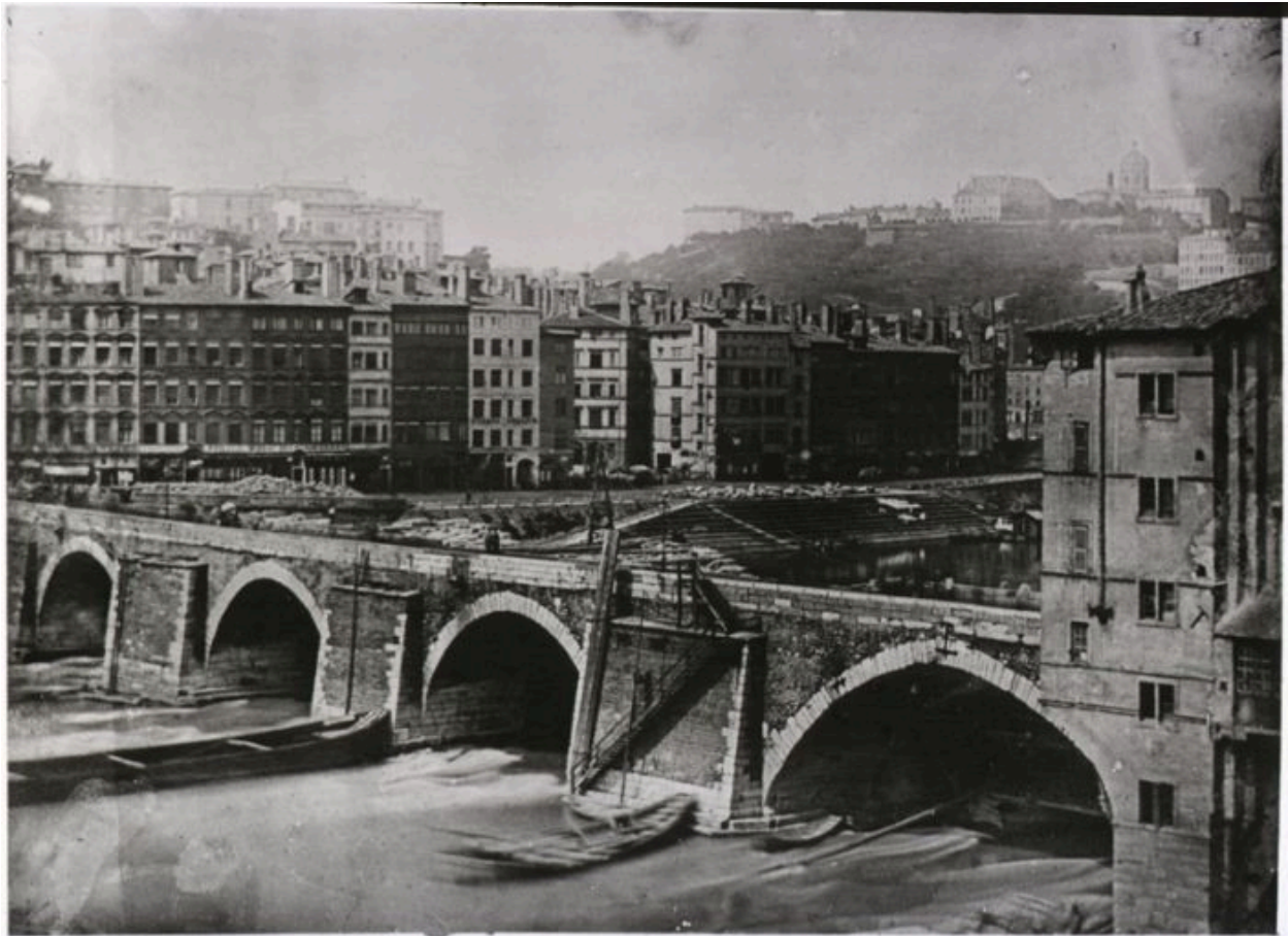
Le Pont de Pierre lors de la construction du nouveau pont, 1844-1845
