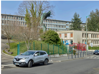
Vue d'ensemble : entrée, accueil et bâtiment principal Phot. Christian Parisey IVR84_20214200040NUCA
