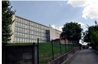
Élévation postérieure Phot. Catherine Guégan IVR84_20224200091NUCA
