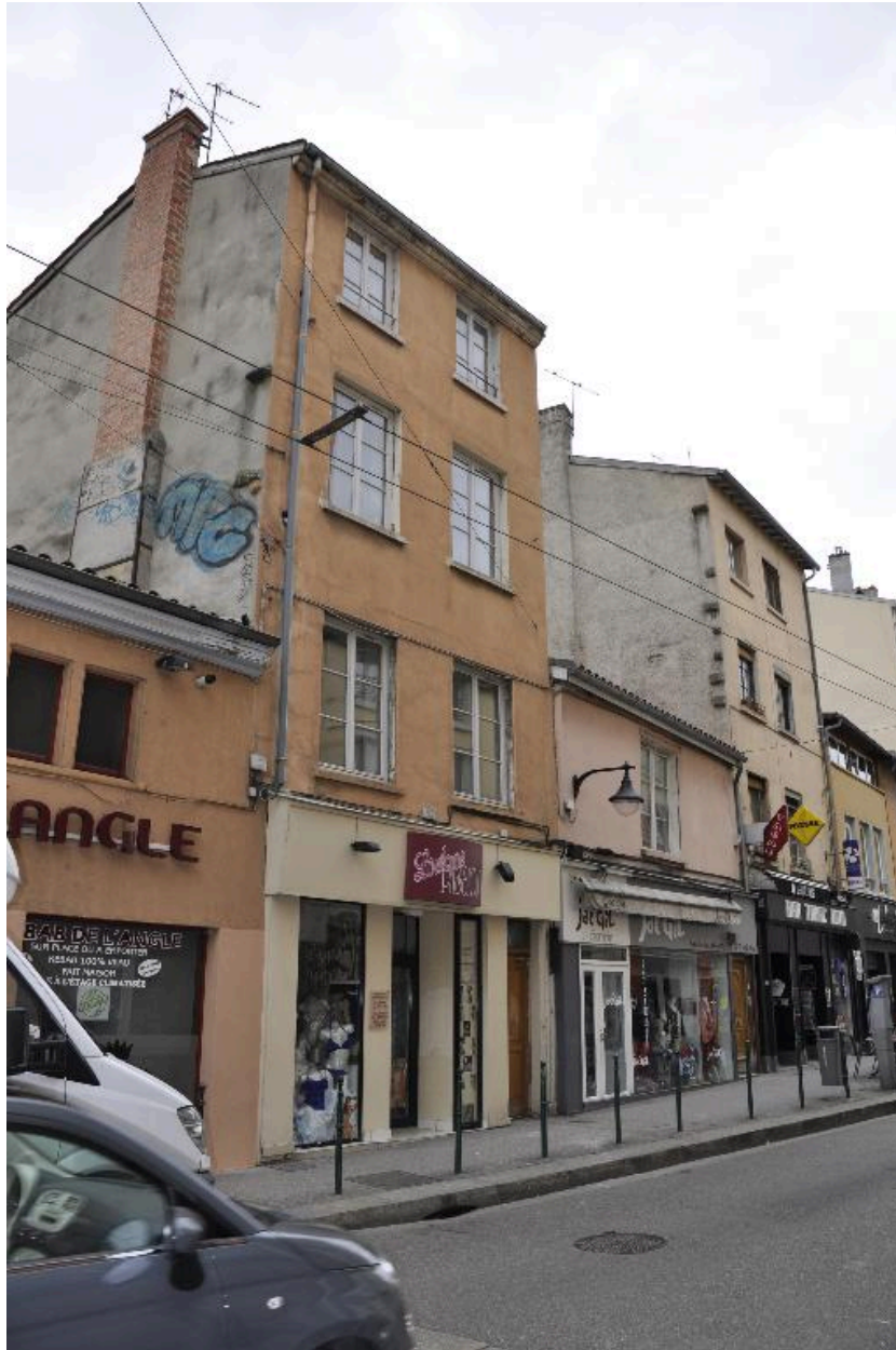
Vue d'ensemble nord ouest de l'immeuble de trois étages
