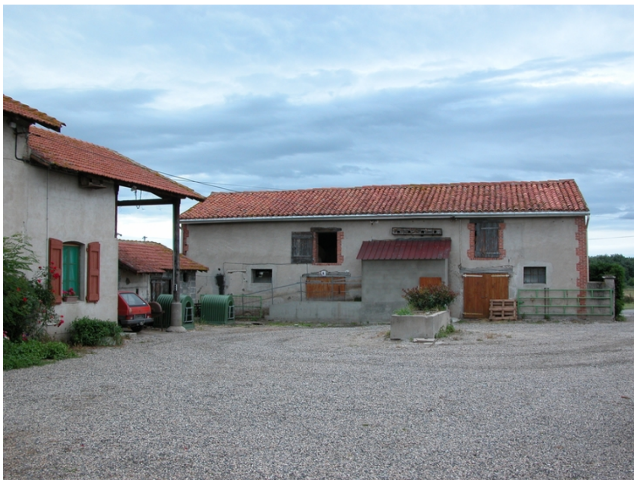
Vue du bâtiment est : étables.
