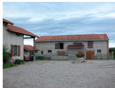
Vue du bâtiment est : étables. Phot. Thierry Monnet IVR82_20134201892NUCA
