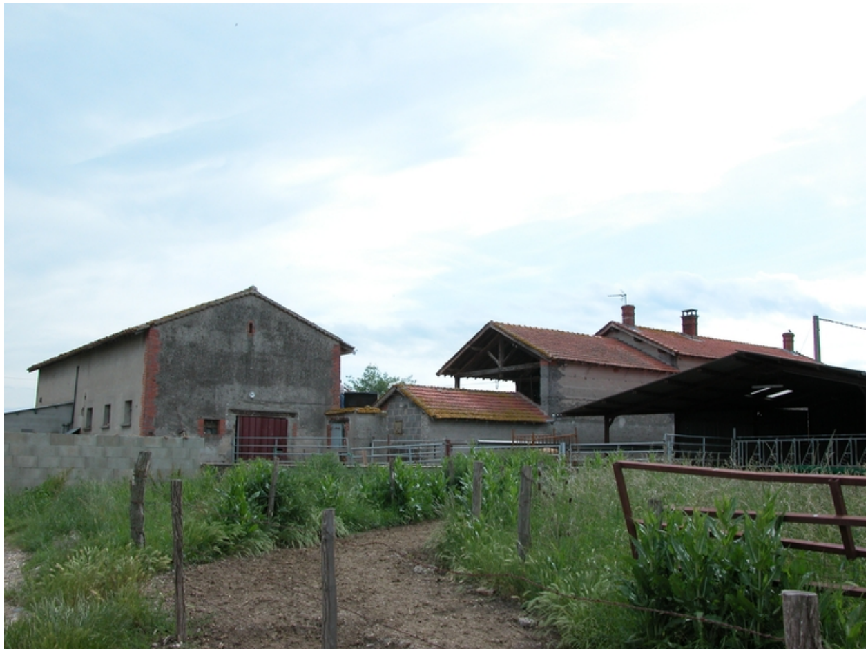
Vue arrière du logis neuf et de l'étable est
