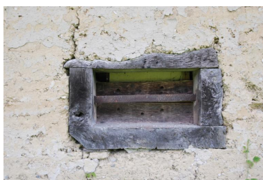
Détail d'ouverture : jour dans le mur nord, partie est. Phot. Thierry Monnet IVR84_20207400265NUCA
