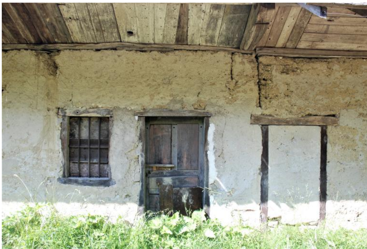
Façade de la partie habitation.
