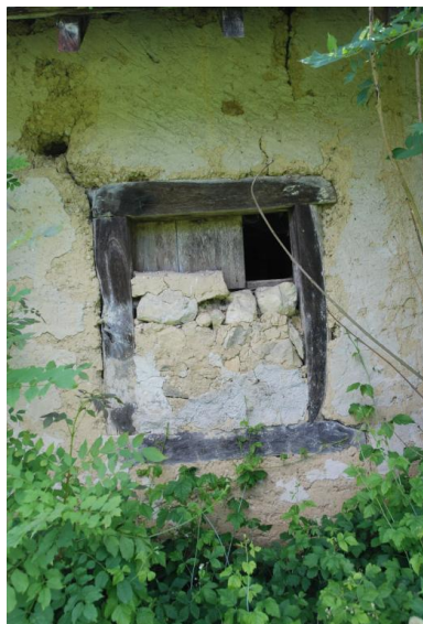
Détail d'ouverture : fenêtre murée.
