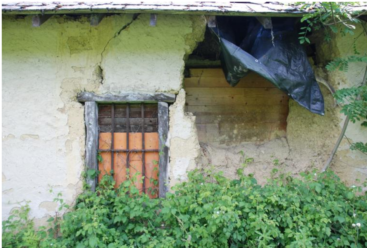
Détail d'ouvertures : mur nord.
