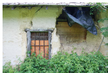
Détail d'ouvertures : mur nord. Phot. Thierry Monnet IVR84_20207400266NUCA
