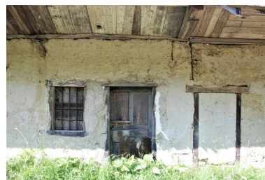
Façade de la partie habitation. Phot. Thierry Monnet IVR84_20207400272NUCA
