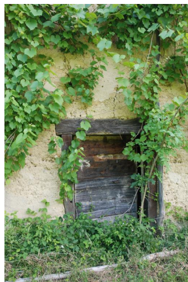
Porte sur le mur pignon est. Phot. Thierry Monnet IVR84_20207400263NUCA
