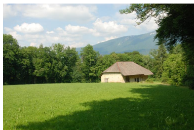
Vue de situation. Phot. Thierry Monnet IVR84_20207400259NUCA
