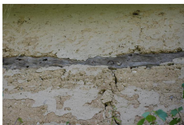
Détail de l'entrait pris dans le pisé, dernière ferme de charpente côté est. Phot. Thierry Monnet IVR84_20207400264NUCA
