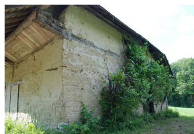
Vue de l'angle sud-est. Phot. Thierry Monnet IVR84_20207400262NUCA
