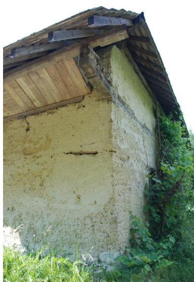
Vue de l'angle sud-est. Phot. Thierry Monnet IVR84_20207400261NUCA
