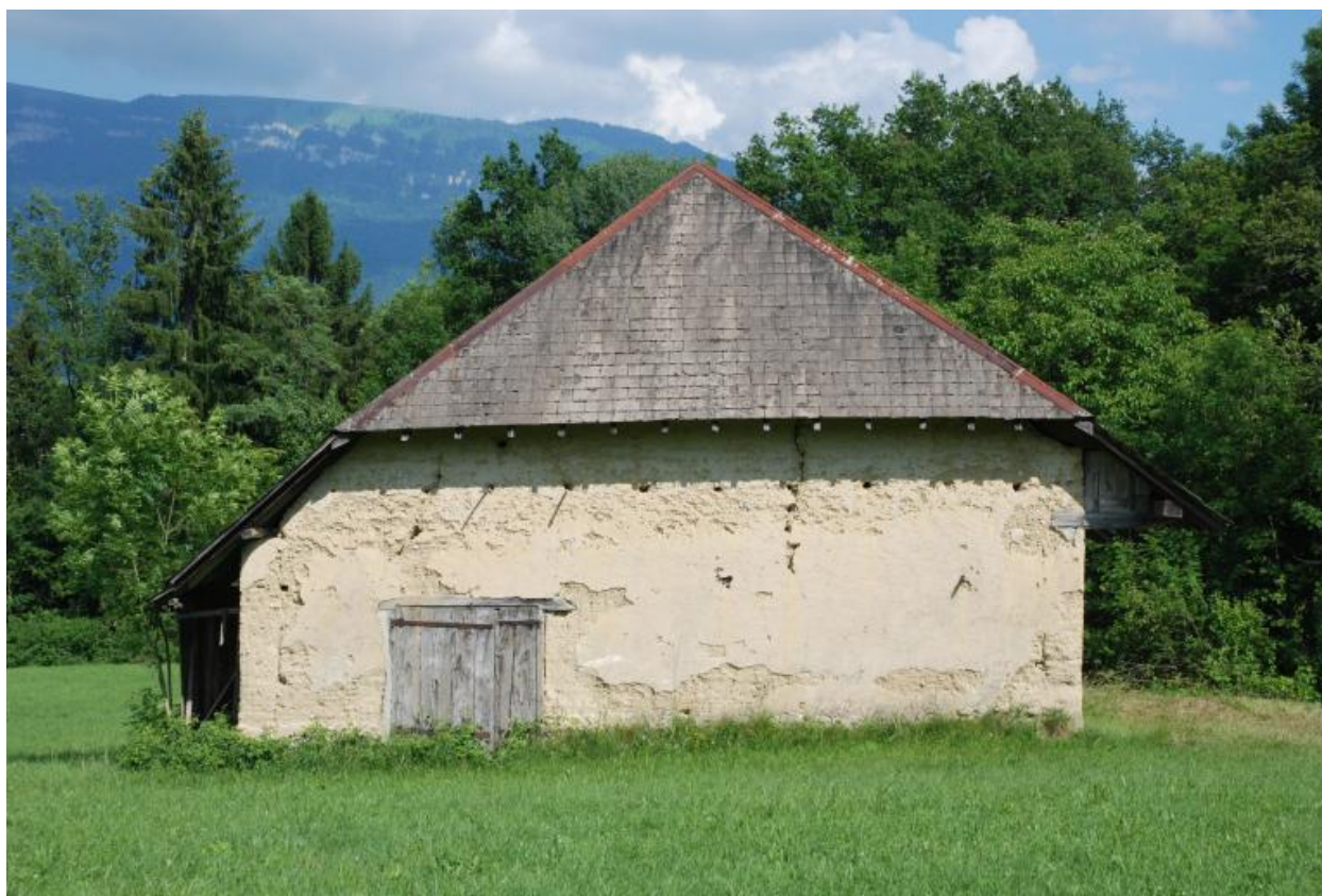
Vue du mur pignon ouest.
