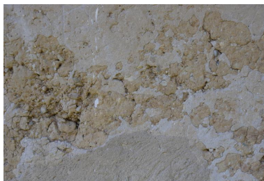
Détail du pisé et de l'enduit.
