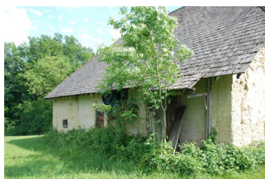
Vue arrière. Phot. Thierry Monnet IVR84_20207400268NUCA
