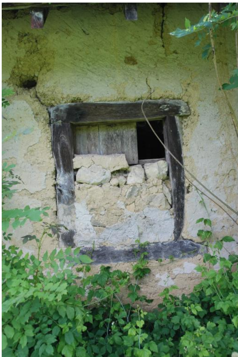
Détail d'ouverture : fenêtre murée.
