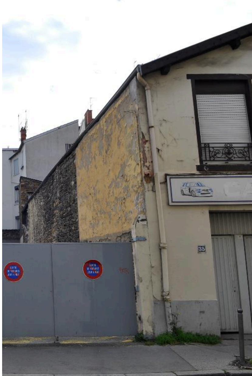
Atelier, élévation latérale nord en moellons apparents
