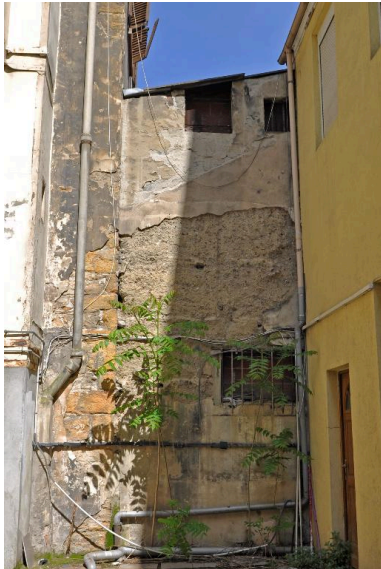
Atelier, mur postérieur en pisé (vu depuis la cour du 67 rue Reinach) Phot. Catherine Guégan IVR84_20176901372NUCA
