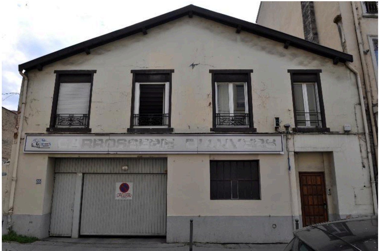
Atelier, vue de l'élévation sur rue
