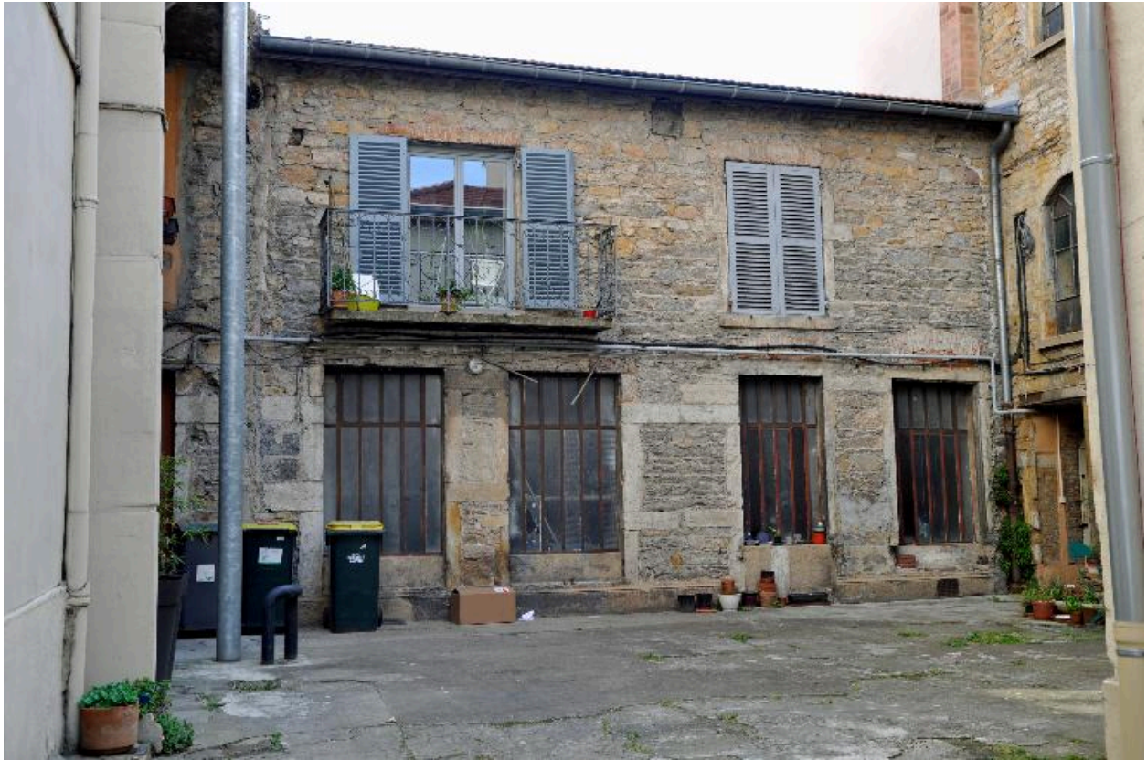
Atelier, vue de l'élévation sur cour en moellons apparents (élévation latérale sud)
