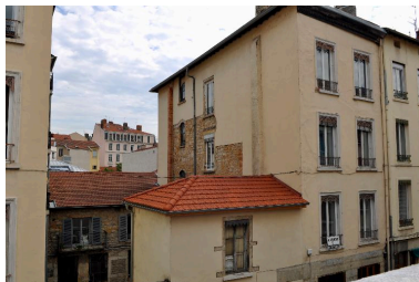
Immeuble 65 rue Reinach, vue partielle sud-ouest Phot. Catherine Guégan IVR84_20176901355NUCA
