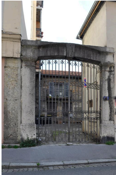
Vue du portail en ferronnerie et pierre de taille Phot. Catherine Guégan IVR84_20176901356NUCA
