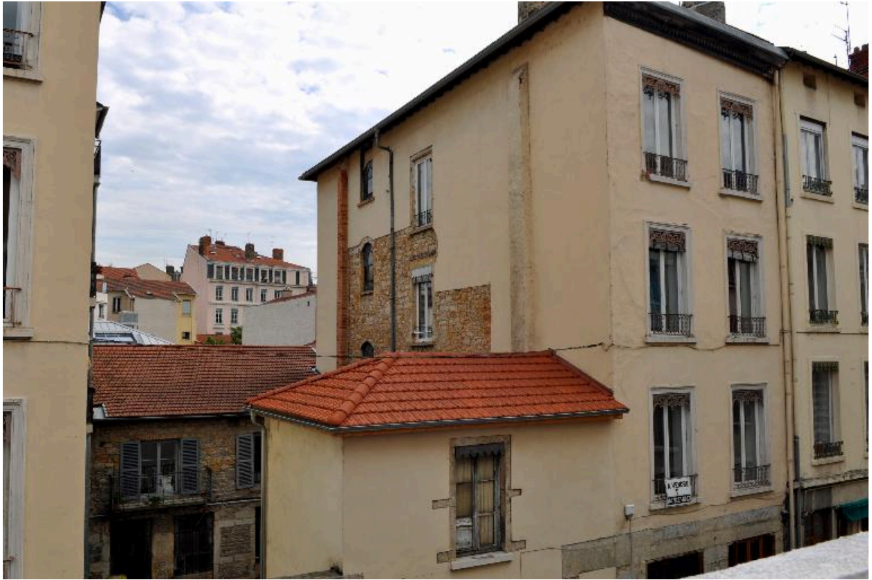
Immeuble 65 rue Reinach, vue partielle sud-ouest
