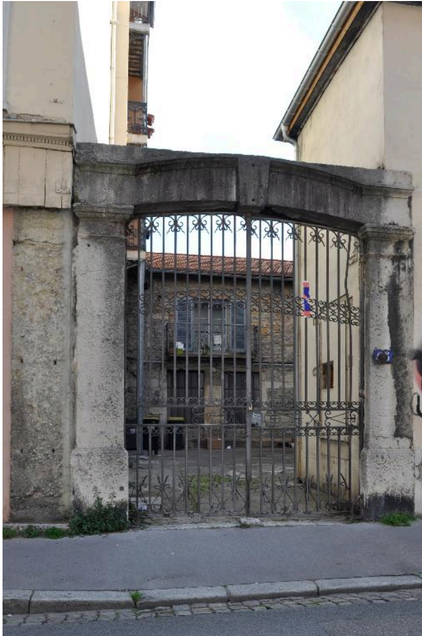
Vue du portail en ferronnerie et pierre de taille
