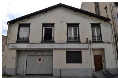
Atelier, vue de l'élévation sur rue Phot. Catherine Guégan IVR84_20176901370NUCA
