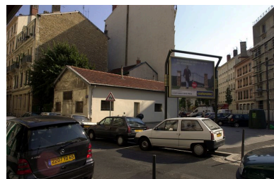
Vue de l'atelier appelé à être démoli Phot. Bernard Ducouret IVR82_20036903272NUCA
