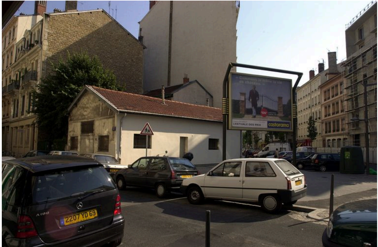
Vue de l'atelier appelé à être démoli
