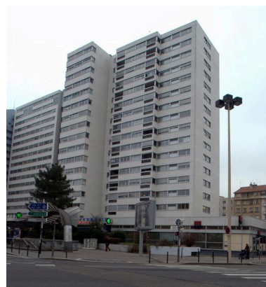
Les corps de bâtiment nord depuis l'est Phot. Maryannick Chalabi IVR82_20086900723NUCA
