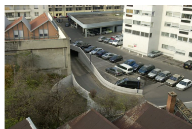
Le parc de stationnement depuis l'est, côté rue Garibaldi Phot. Maryannick Chalabi IVR82_20086900658NUCA
