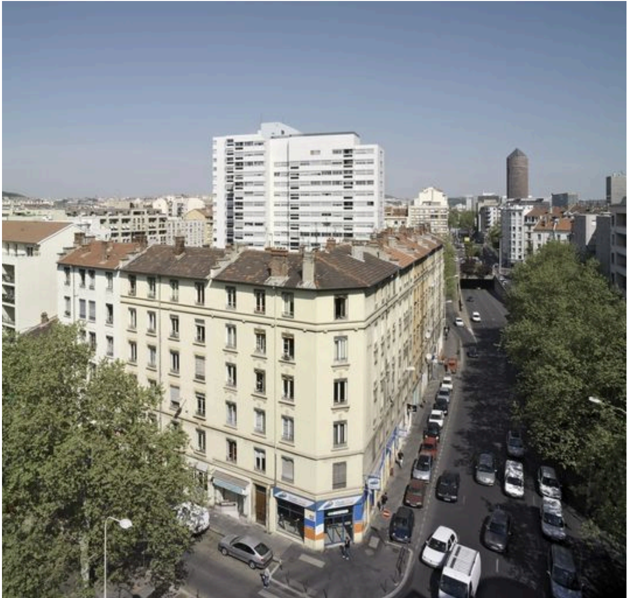
Vue générale depuis le sud
