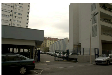
Entrée du parc de stationnement, rue André-Philip Phot. Maryannick Chalabi IVR82_20086900657NUCA
