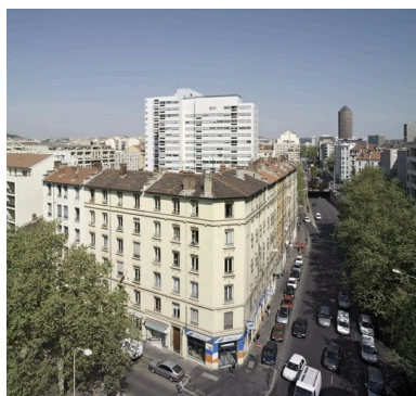
Vue générale depuis le sud Phot. Eric Dessert IVR82_20076902421NUCA
