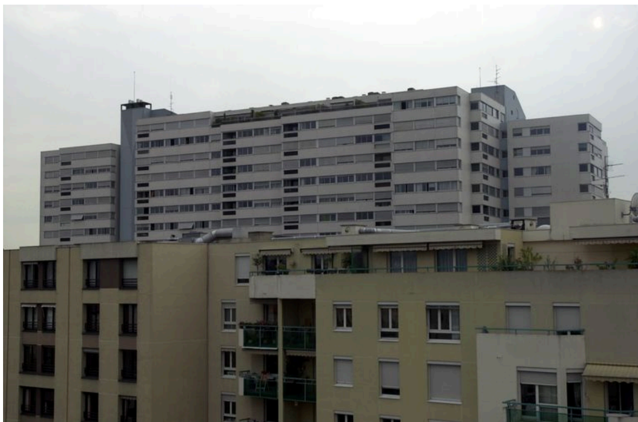
Elévation ouest, partie supérieure
