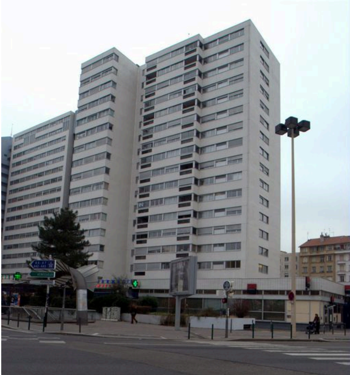
Les corps de bâtiment nord depuis l'est
