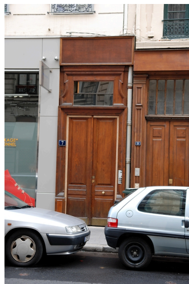
La porte piétonne Phot. Véronique Belle IVR82_20096904668NUCA
