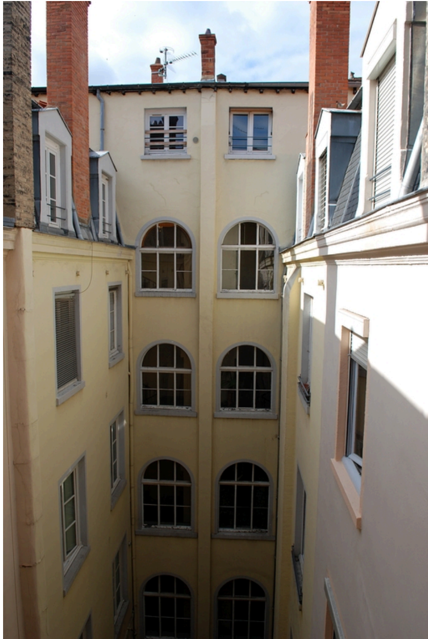
Elévation sur cour depuis l'escalier desservant le 5 rue Gasparin
