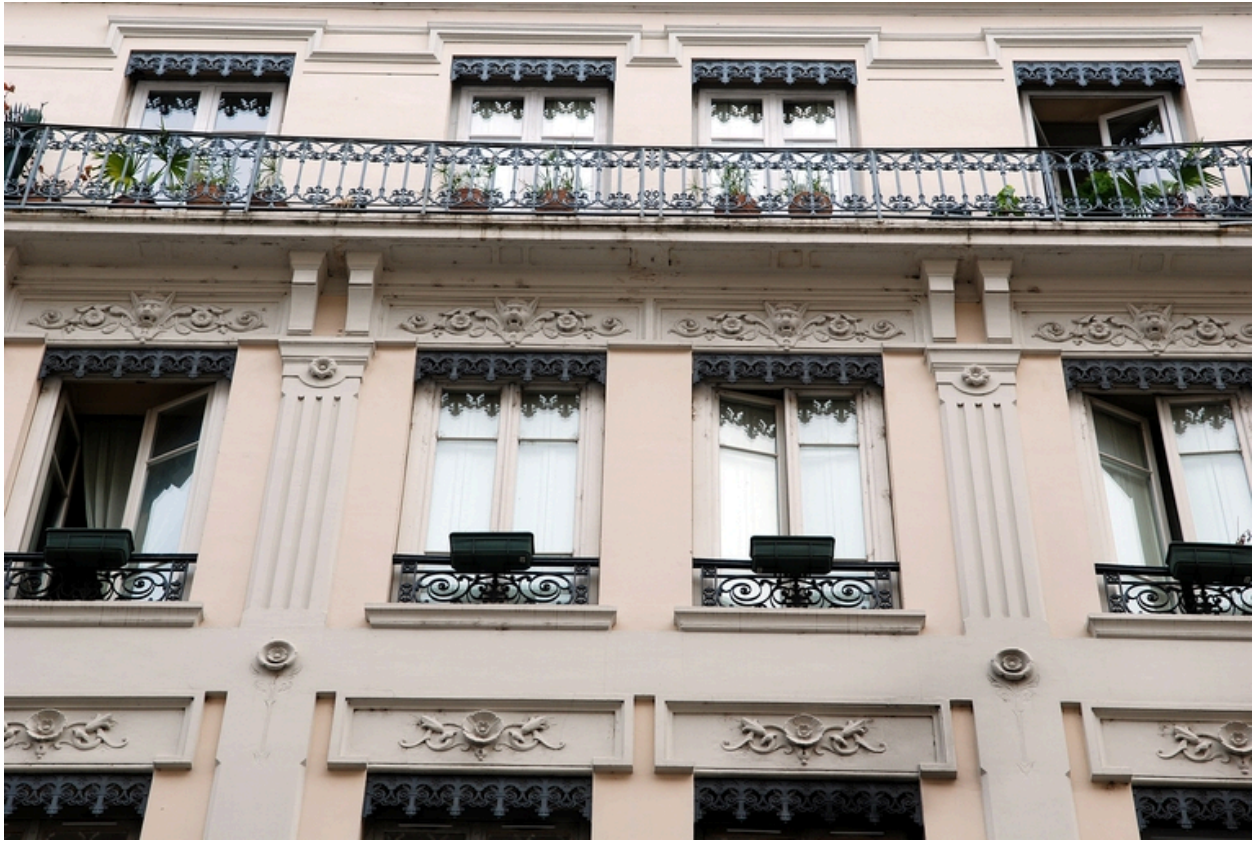
Elévation antérieure : vue partielle
