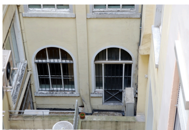
Elévation sur cour : le premier étage carré Phot. Véronique Belle IVR82_20096904673NUCA
