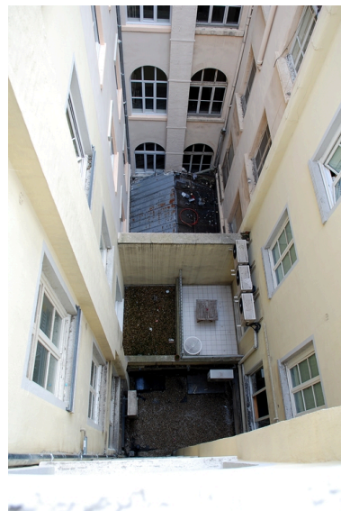
La cour : vue en plongée Phot. Véronique Belle IVR82_20096904671NUCA
