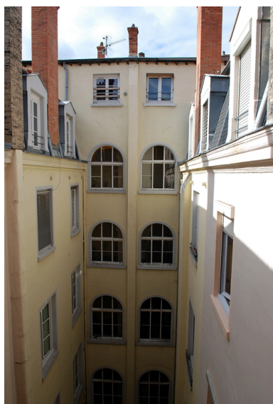
Elévation sur cour depuis l'escalier desservant le 5 rue Gasparin Phot. Véronique Belle IVR82_20096904672NUCA
