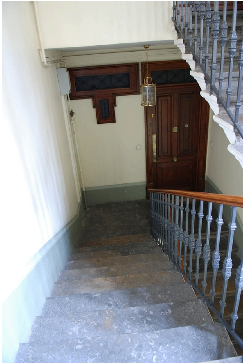
Escalier, porte palière et fenêtre de second jour
