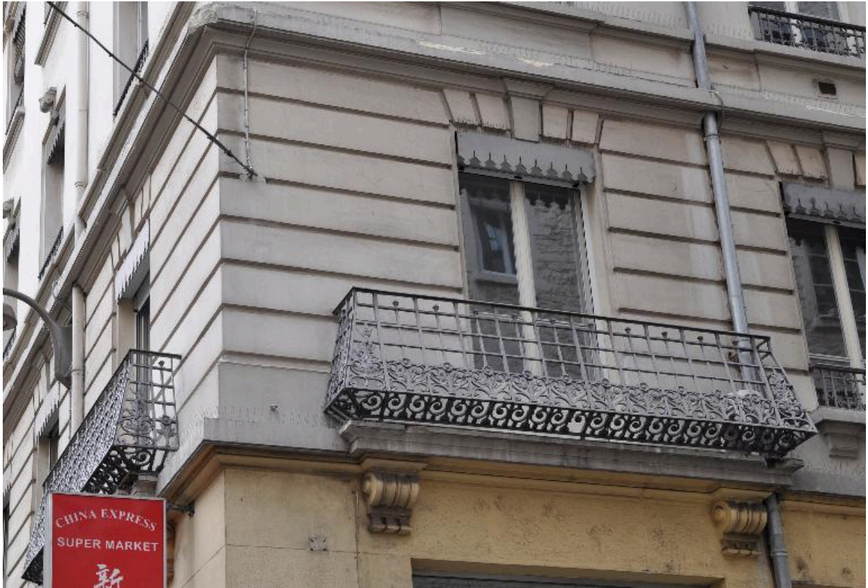
Détail des balcons sur l'angle
