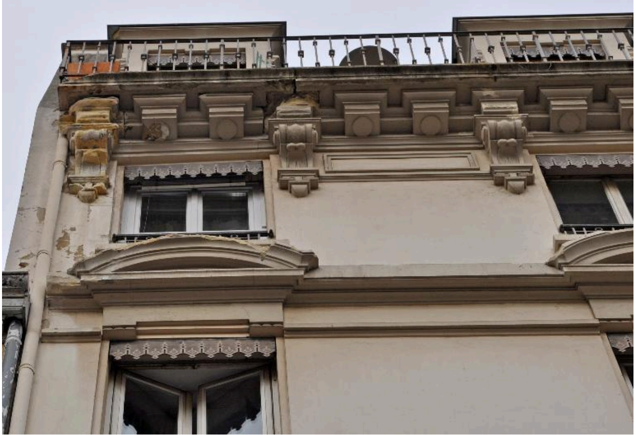
Élévation sur la rue Pasteur, détail du couronnement
