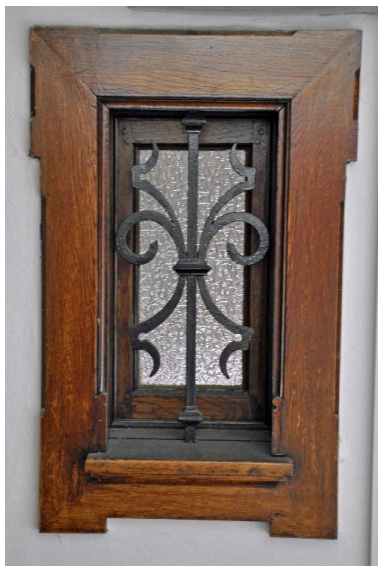
Fenêtre de second jour, ouvrant sur un palier Phot. Magali Delavenne IVR84_20166900668NUCA
