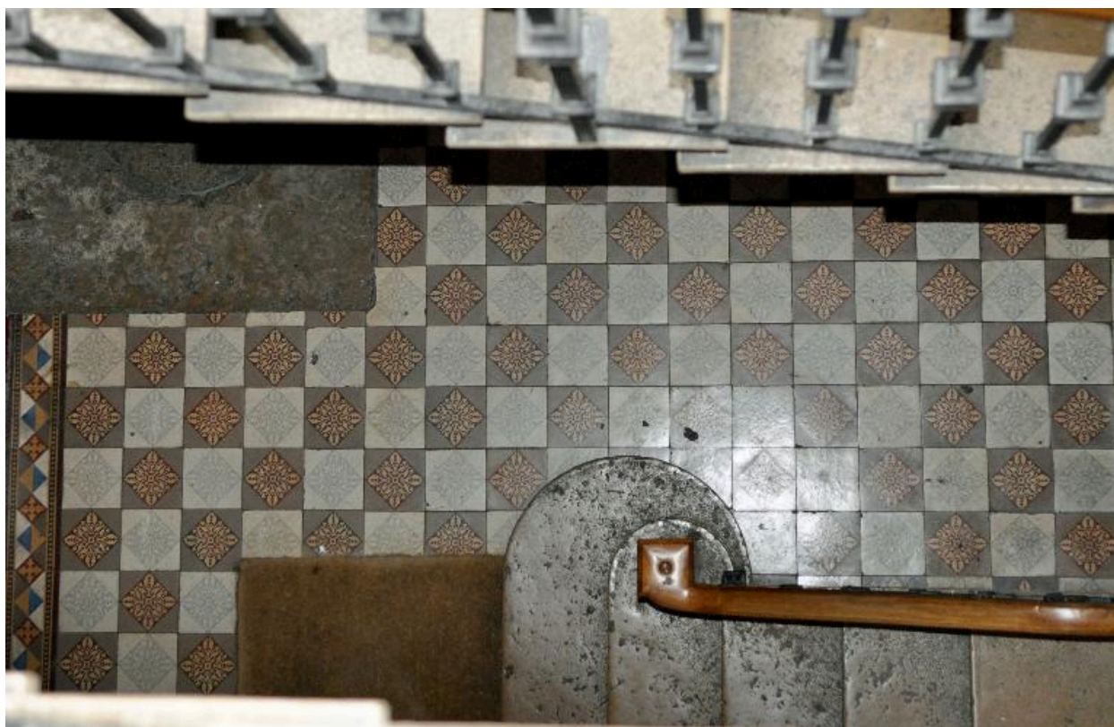
Détail du pavement de la cage d'escalier
