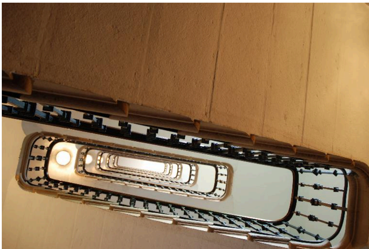
Vue de l'escalier en contre-plongée
