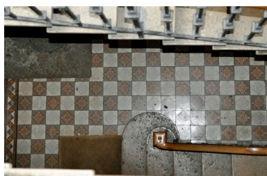
Détail du pavement de la cage d'escalier Phot. Magali Delavenne IVR84_20166900665NUCA
