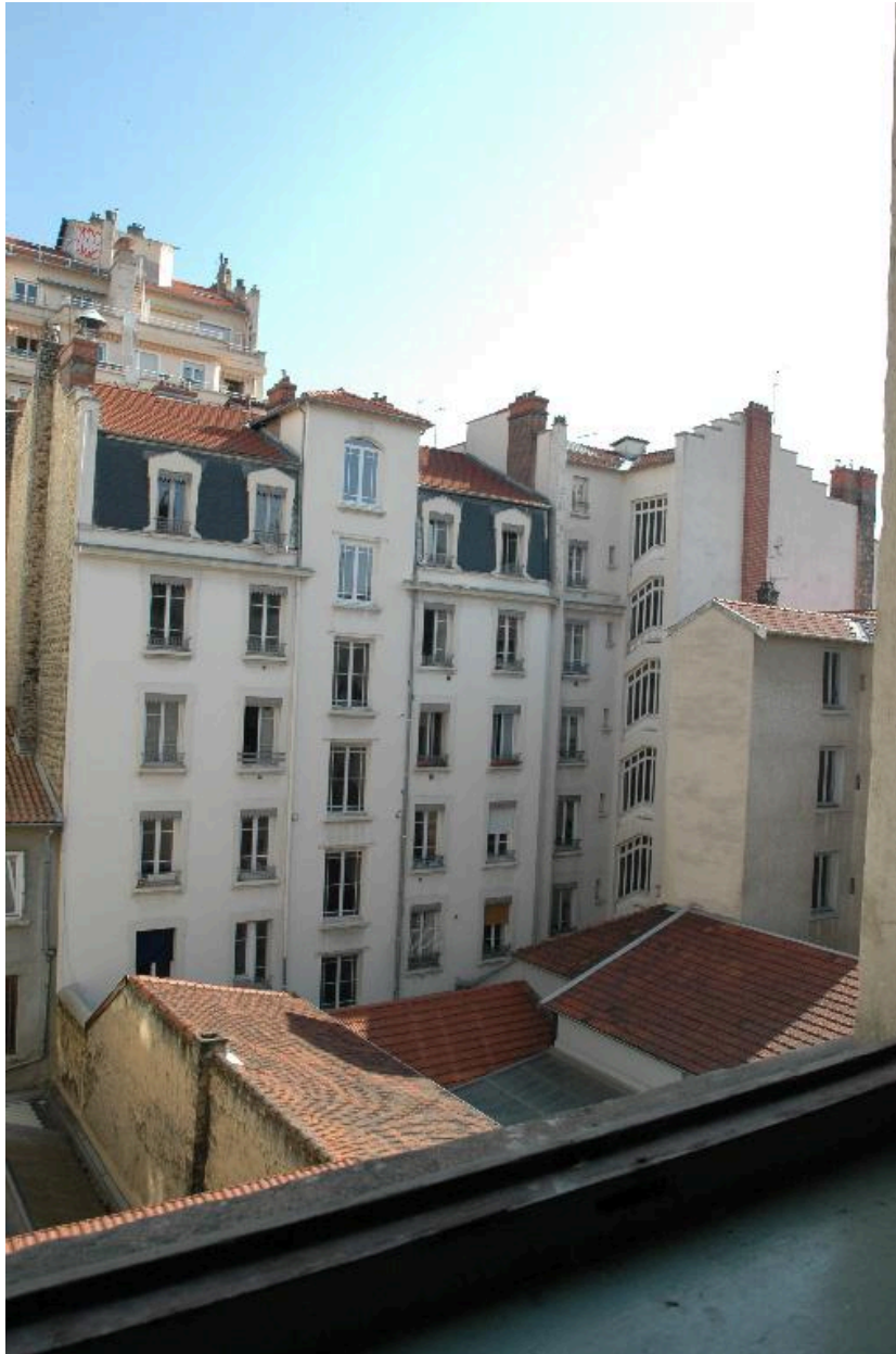
Vue générale des élévations postérieures
