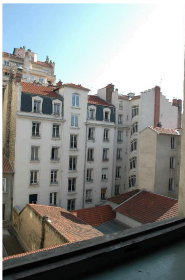
Vue générale des élévations postérieures
