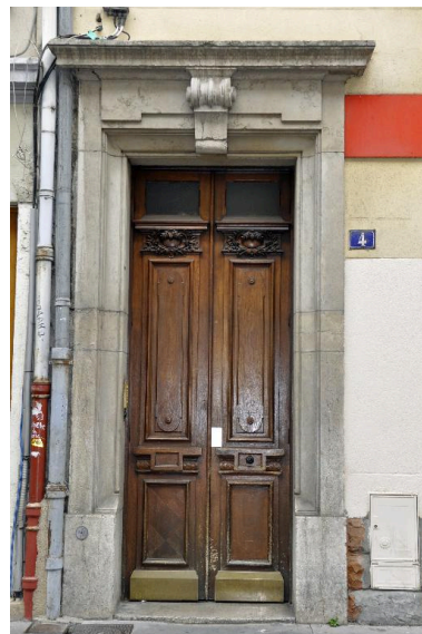
Elévation sur la rue Pasteur, détail de la porte d'entrée Phot. Magali Delavenne IVR84_20166900660NUCA
