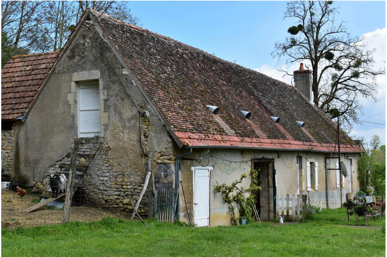
Vue générale de la maison bloc de trois-quarts.
