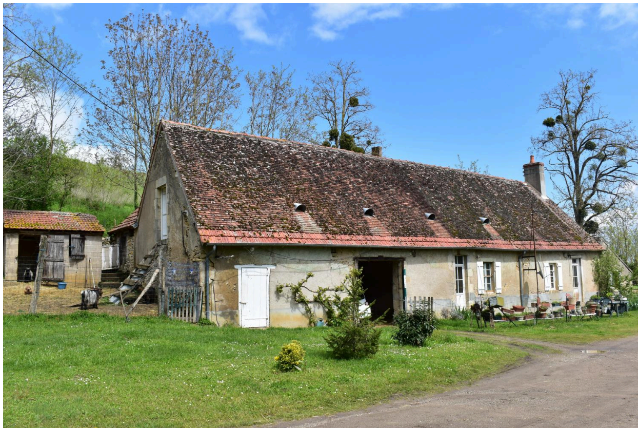
Vue générale de la maison-bloc
