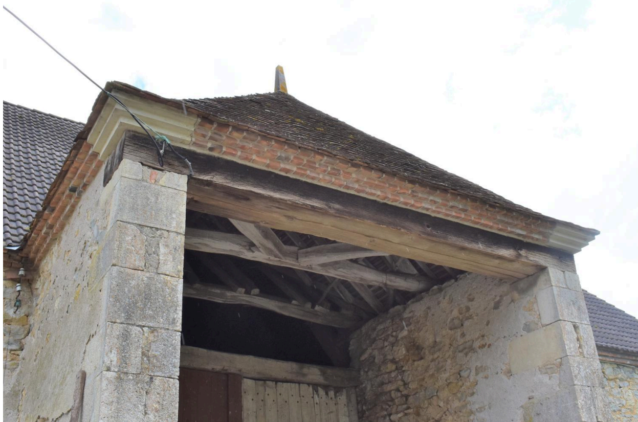
Détails de l'auvent : chainage d'angle, corniche de briques et croupe.
