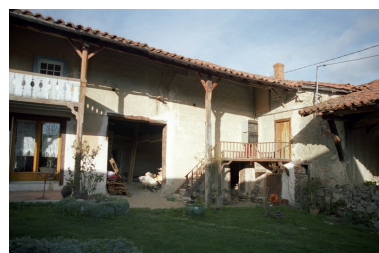
Vue du cuvage et du logement de valet situé à côté du passage couvert. Phot. Thierry Monnet IVR82_20044200688ZE
