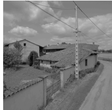
Vue générale des bâtiments depuis le sud. Phot. Eric Dessert IVR82_20024202652X
