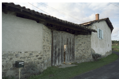
Vue d'ensemble depuis le chemin : passage couvert. Phot. Thierry Monnet IVR82_20044200685ZE
