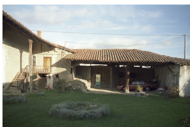
Vue d'ensemble du passage couvert, depuis le fond de la cour. Phot. Thierry Monnet IVR82_20044200687ZE
