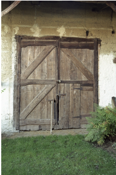
Vue de la porte de la grange. Phot. Thierry Monnet IVR82_20044200690ZE
