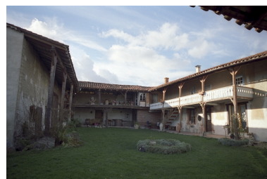
Vue d'ensemble de la cour, depuis le passage couvert. Phot. Thierry Monnet IVR82_20044200686ZE
