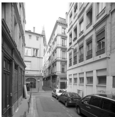
Vue sur l'angle entre la rue Longue et la rue Pléney Phot. Didier Gourbin IVR82_20056901538NUC
