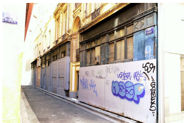
Alignement des boutiques rue Pléney des immeubles 39 (au 1er plan) et 41, rue Paul-Chenavard Phot. Bernard Ducouret IVR82_20046900138NUCA
