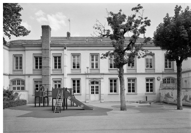
Ecoles primaires : partie centrale de l'élévation postérieure Phot. Jean-Marie Refflé IVR82_20016901098P
