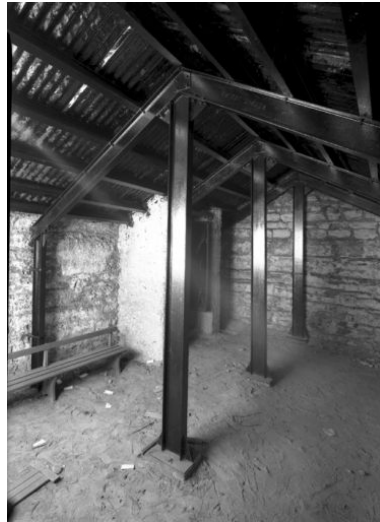
Ecole maternelle : vue partielle d'une cave construite en pierre et renforcée par une charpente métallique Phot. Jean-Marie Refflé IVR82_20016902298P
