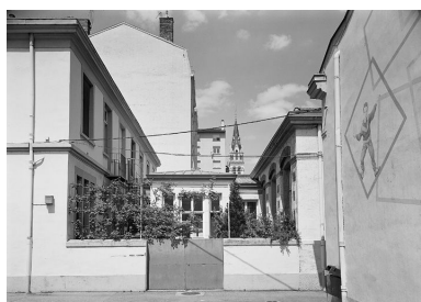
Ecole maternelle : vue des bâtiments prise depuis la cour sud-ouest. A l'arrière-plan, le clocher de l'église Sainte-Blandine Phot. Jean-Marie Refflé IVR82_20016902233P
