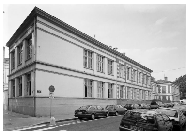
Ecoles primaires : élévation antérieure Phot. Jean-Marie Refflé IVR82_20016901094P
