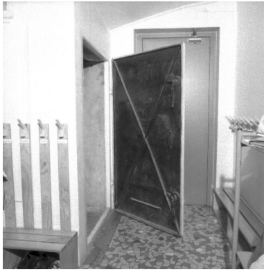
Ecole maternelle : porte d'accès aux caves située sous l'escalier principal Phot. Jean-Marie Refflé IVR82_20016902297X
