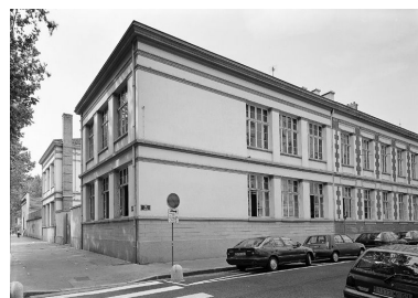
Ecoles primaires : élévation sud et vue partielle de l'élévation Est Phot. Jean-Marie Refflé IVR82_20016901097P
