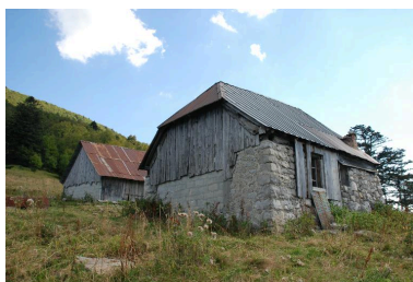
Vue d'ensemble depuis le nord-ouest. Phot. Thierry Monnet IVR84_20167306723NUCA
