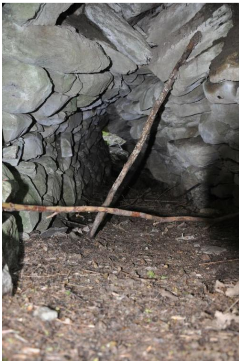
Tronçon souterrain du canal de dérivation.
