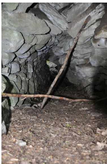
Tronçon souterrain du canal de dérivation. Phot. Clara Bérelle IVR84_20197300200NUCA
