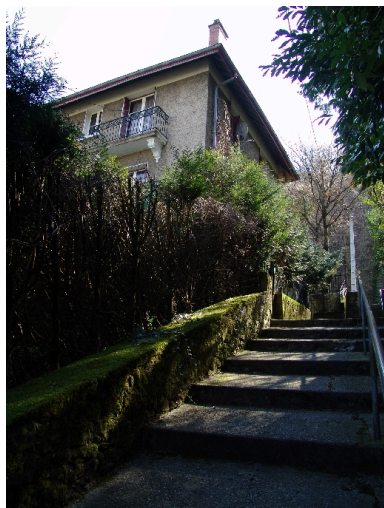
Vue depuis le sud-ouest Phot. François Fouger IVR82_20097300513NUCA
