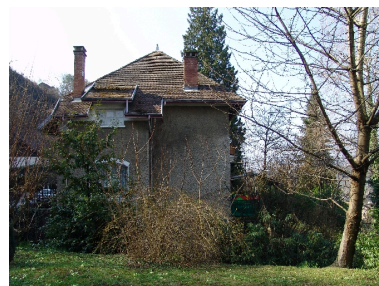
Élévation latérale droite Phot. François Fouger IVR82_20097300511NUCA
