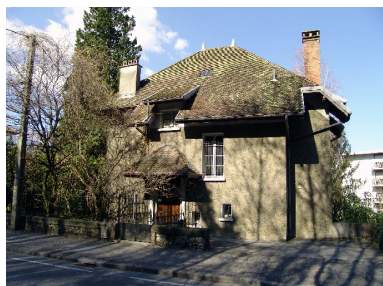
Façade sur rue Phot. François Fouger IVR82_20097300514NUCA
