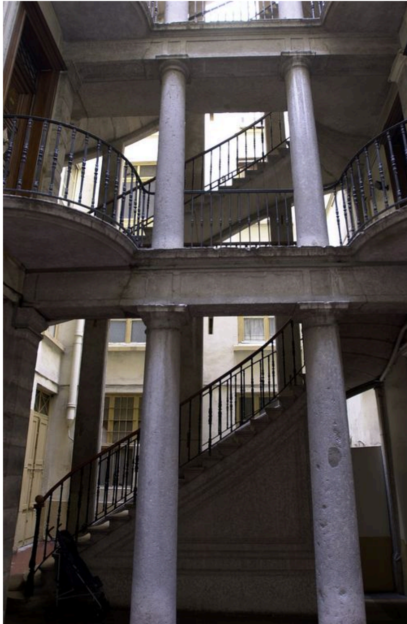
Les deux premiers niveaux de l'escalier, vus depuis la cour où sera installé l'ascenseur
