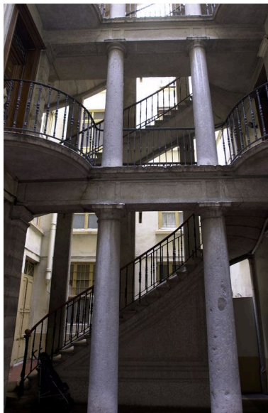
Les deux premiers niveaux de l'escalier, vus depuis la cour où sera installé l'ascenseur Phot. Véronique Belle IVR82_20036902020NUCA
