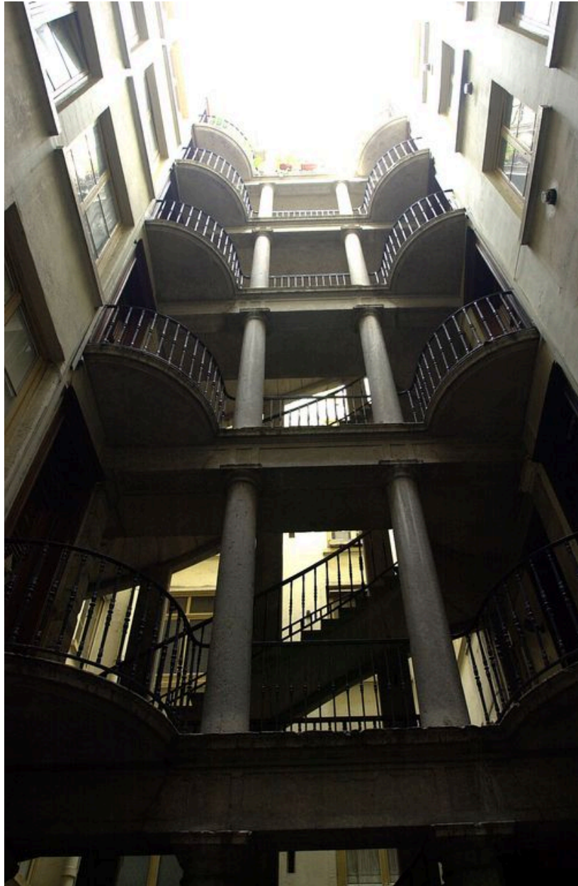
Cage d'escalier, vue depuis la cour où sera installé l'ascenseur
