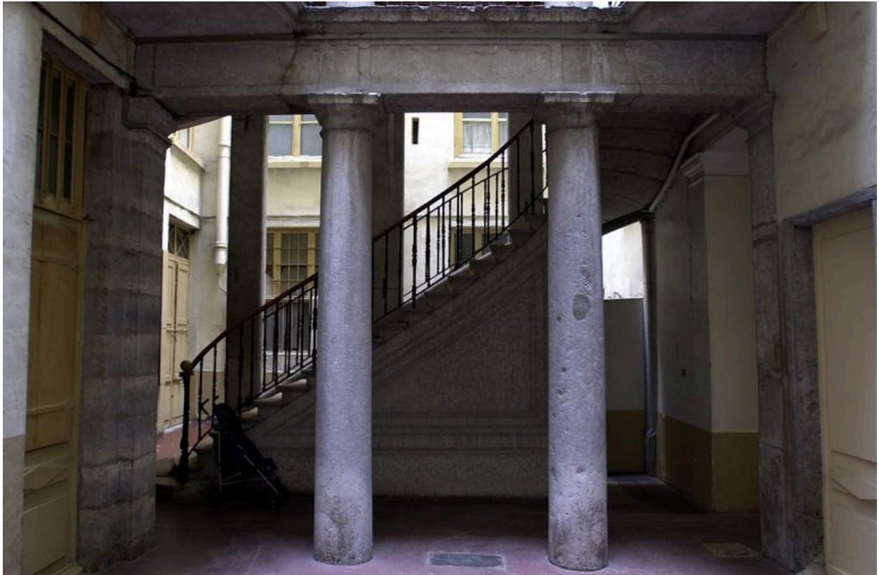
Cage d'escalier au niveau du rez-de-chaussée, vue depuis la cour où sera installée l'ascenseur
