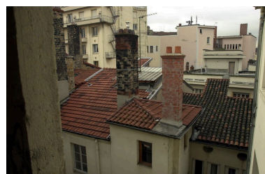
Toiture et ciel ouvert éclairant la cage d'escalier, depuis l'escalier du 8 rue de l'Ancienne-Préfecture Phot. Véronique Belle IVR82_20076901188NUCA
