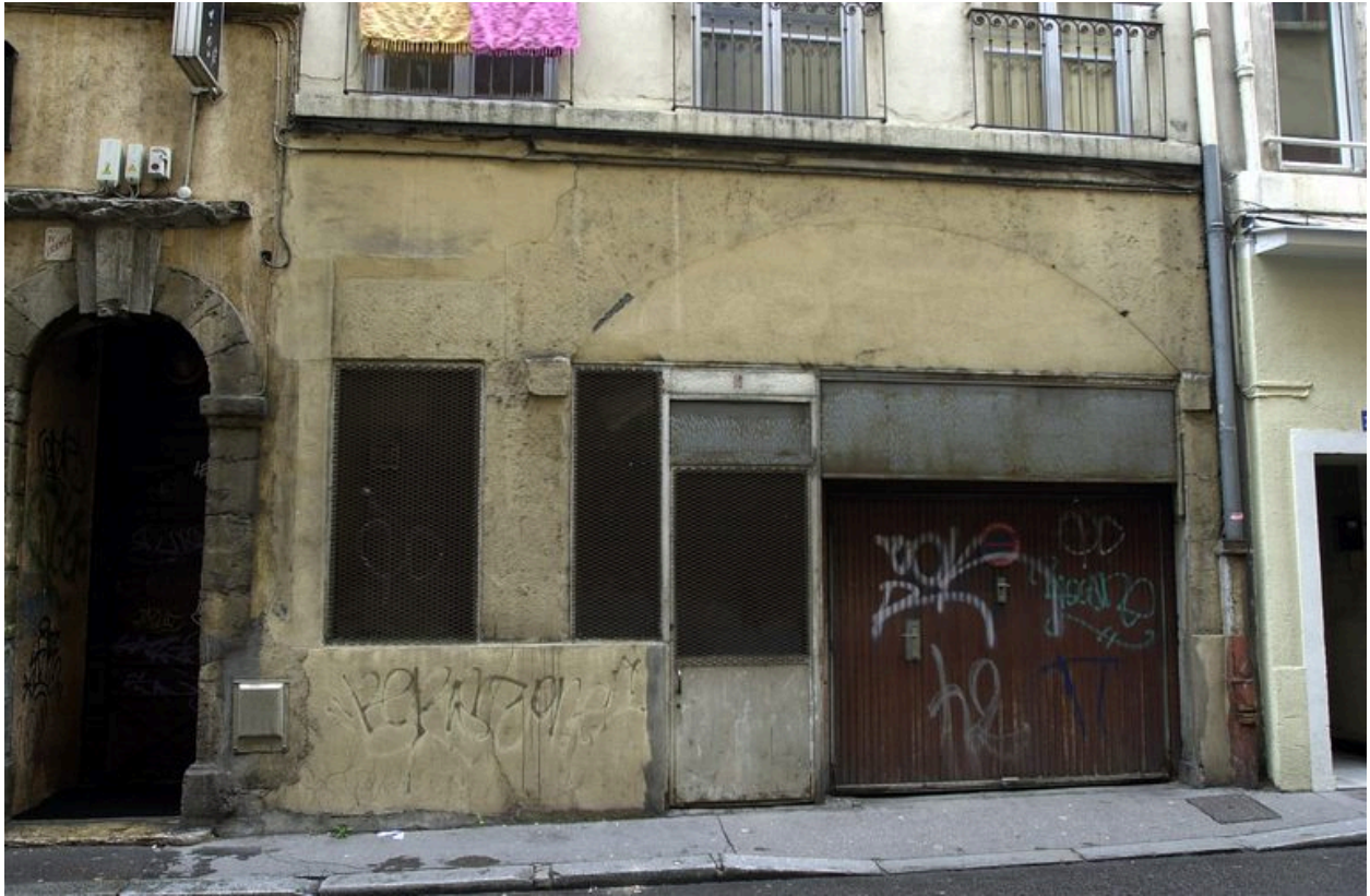
Élévation antérieure : le rez-de-chaussée
