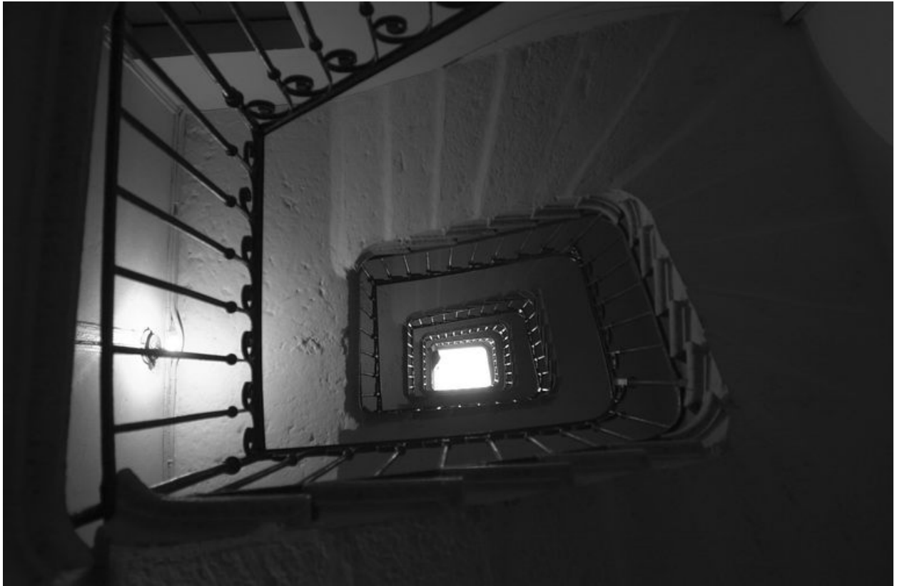
Vue en contre-plongée de l'escalier
