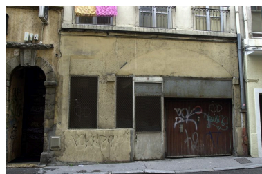
Elévation antérieure : le rez-de-chaussée Phot. Véronique Belle IVR82_20076901183NUCA
