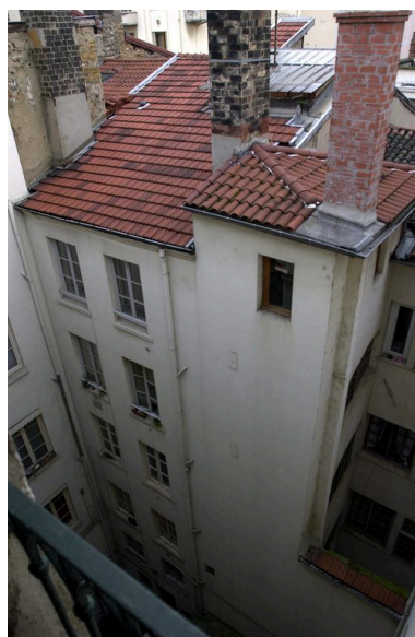
A gauche, l'élévation sur cour Phot. Véronique Belle IVR82_20076901187NUCA
