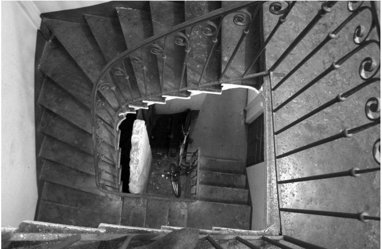
Vue en plongée de l'escalier
