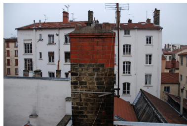
Vue partielle de l'élévation sur cour (à gauche) Phot. Magali Delavenne IVR84_20166902422NUCA
