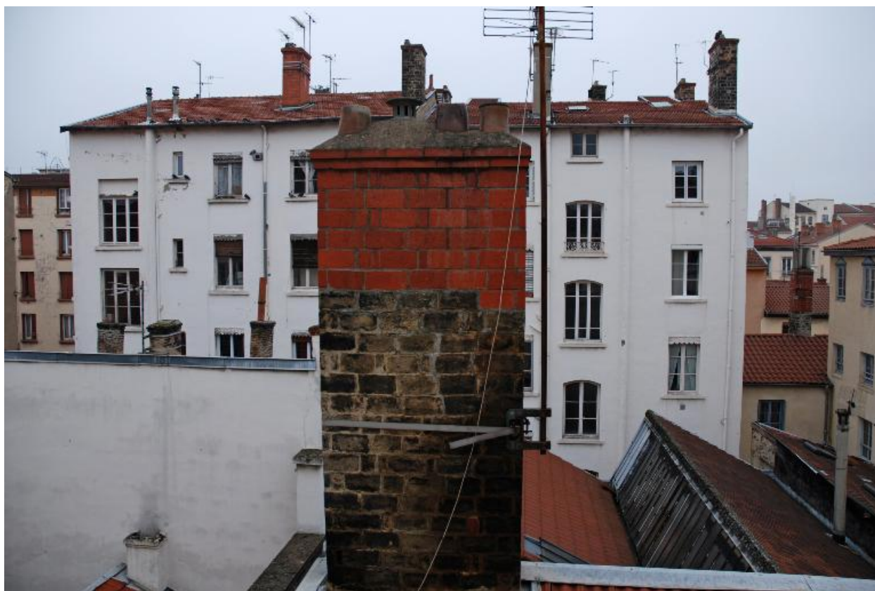
Vue partielle de l'élévation sur cour (à gauche)
