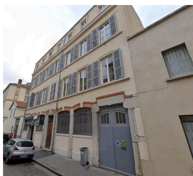
Vue du bâtiment administratif Phot. Nadine Halitim-Dubois IVR84_20246900018NUCA
