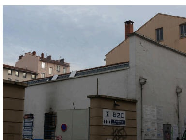
Vue est de la façade Phot. Nadine Halitim-Dubois IVR84_20246900050NUCA
