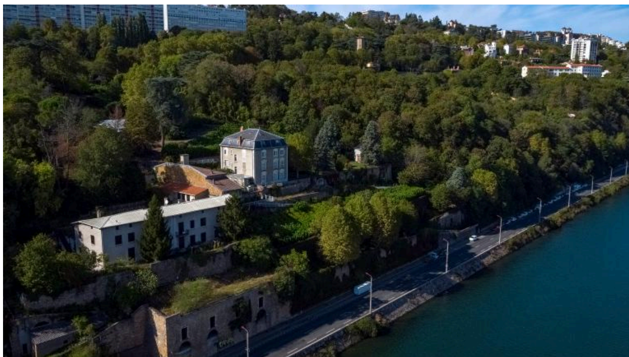
Vue d'ensemble sud-est du centre séricicole (drône)
