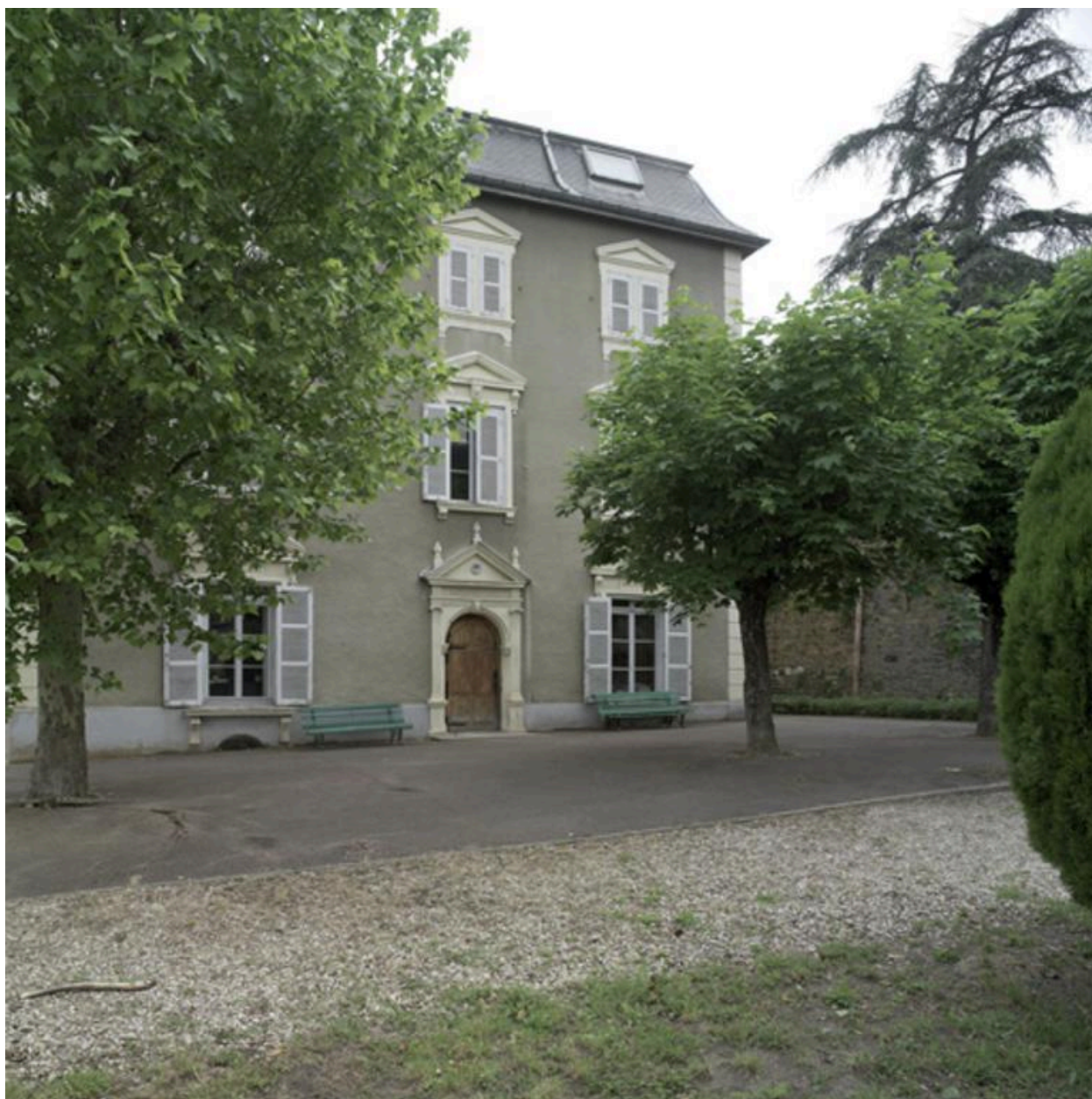
Façade nord du bâtiment principal et jardin.
