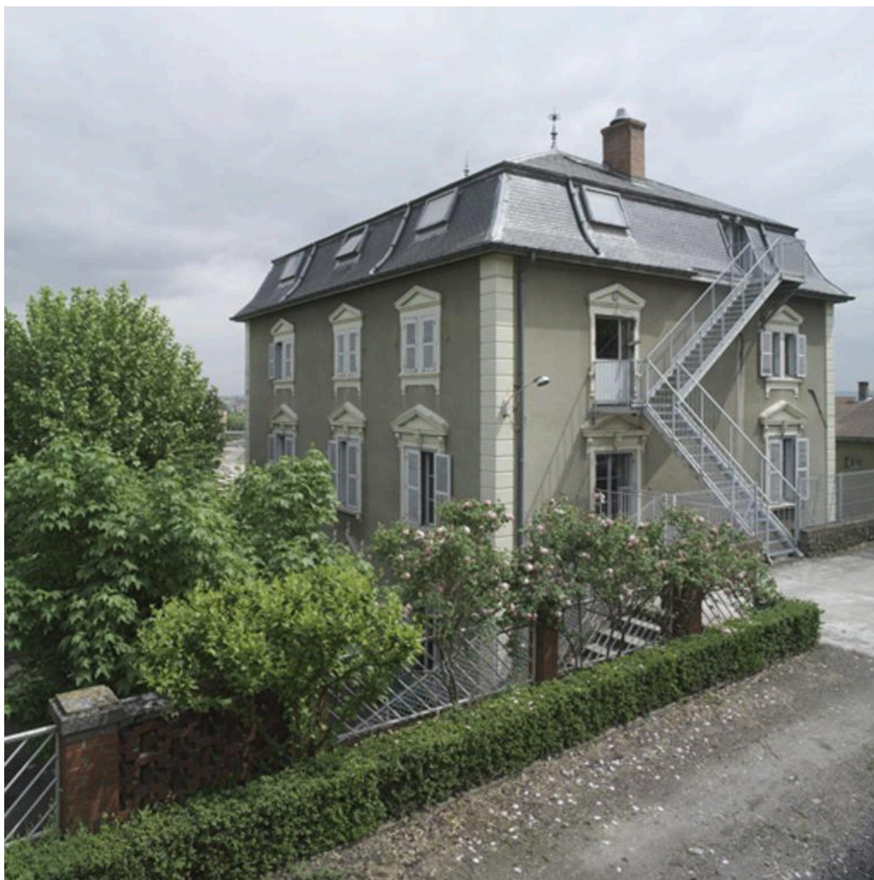
Bâtiment principal : laboratoires de recherches, bibliothèque et ancienne magnanerie.
