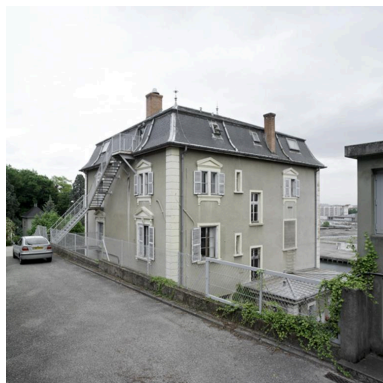
Bâtiment principal. Phot. Eric Dessert IVR82_20086901185NUCA
