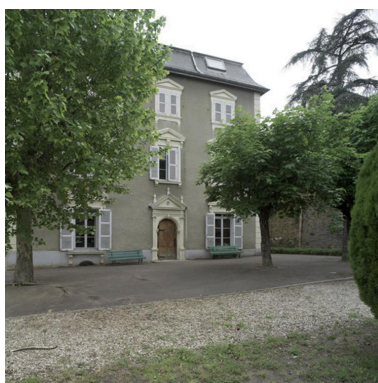
Façade nord du bâtiment principal et jardin. Phot. Eric Dessert IVR82_20086901192NUCA
