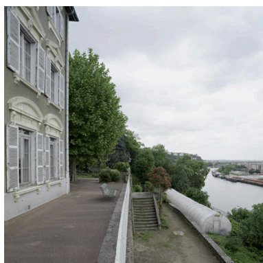
Vue des terrasses du centre de sériciculture. Phot. Eric Dessert IVR82_20086901191NUCA
