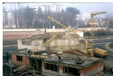
Pose de la première poutre en lamellé-collé par l'entreprise Descotes
