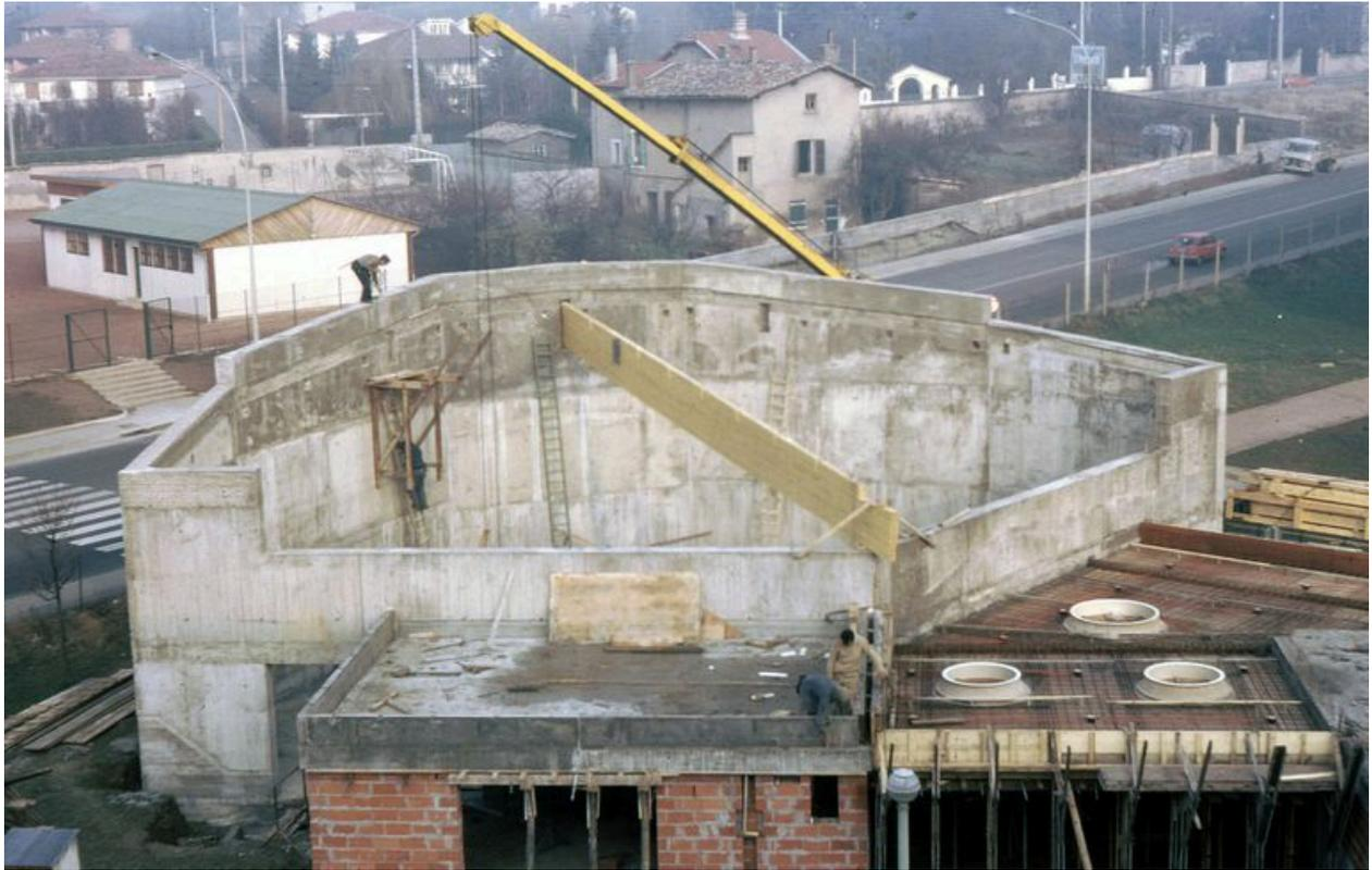
Pose de la première poutre en lamellé-collé
