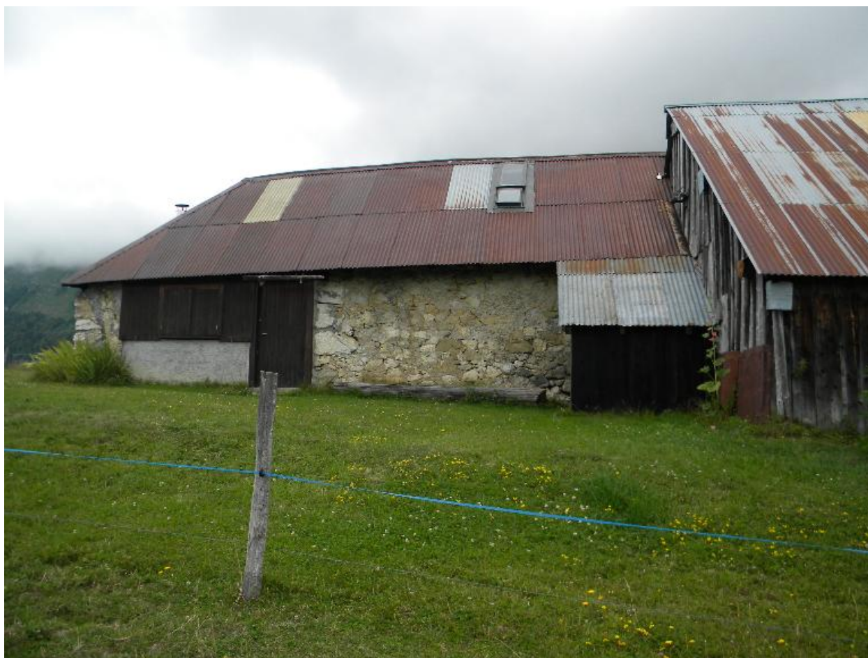
Vue de la partie en maçonnerie de l'étable sud.
