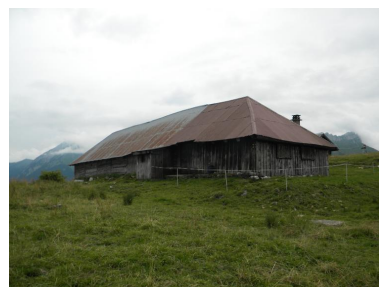
Vue de trois-quarts nord-ouest de l'étable nord. Phot. Jérôme Daviet IVR84_20167306751NUCA
