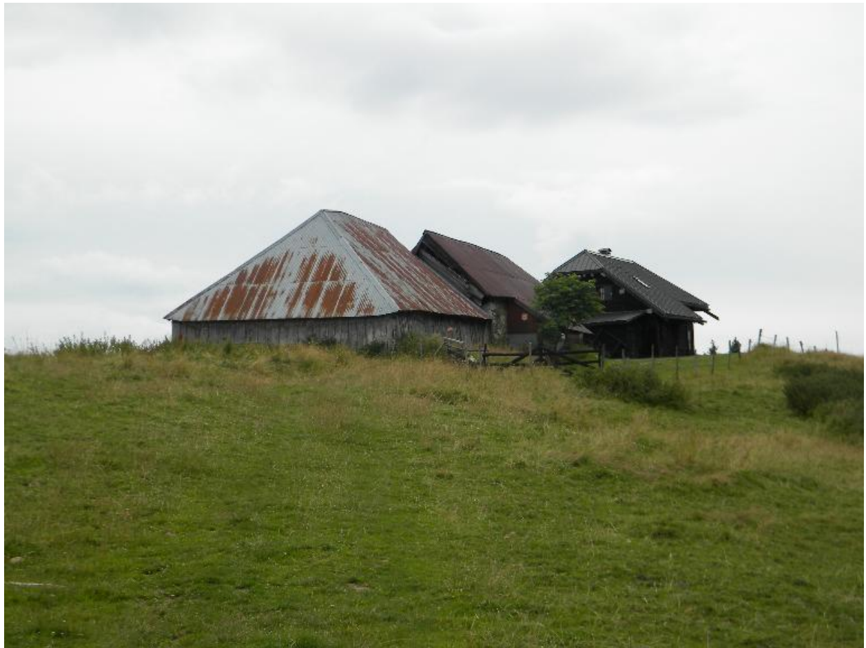
Vue du groupe sud de bâtiments.
