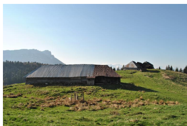
Vue d'ensemble. Phot. Jérôme Daviet IVR84_20167306749NUCA
