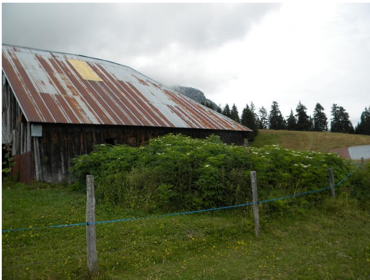
Vue de la partie en bardage de l'étable sud.
