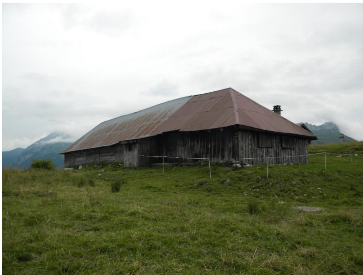
Vue de trois-quarts nord-ouest de l'étable nord.
