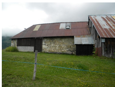
Vue de la partie en maçonnerie de l'étable sud. Phot. Jérôme Daviet IVR84_20167306757NUCA
