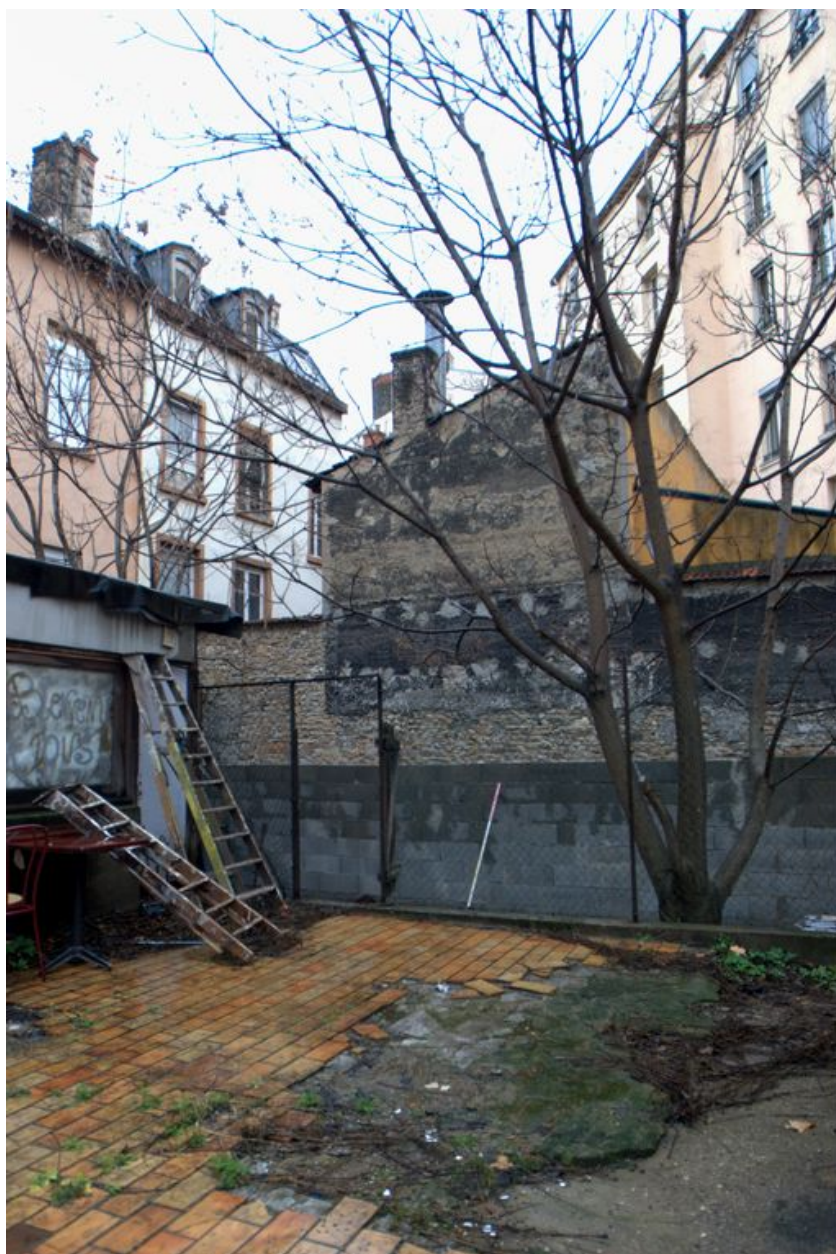
Vue de la cour depuis le sud-ouest et du mur mitoyen construit en galets
