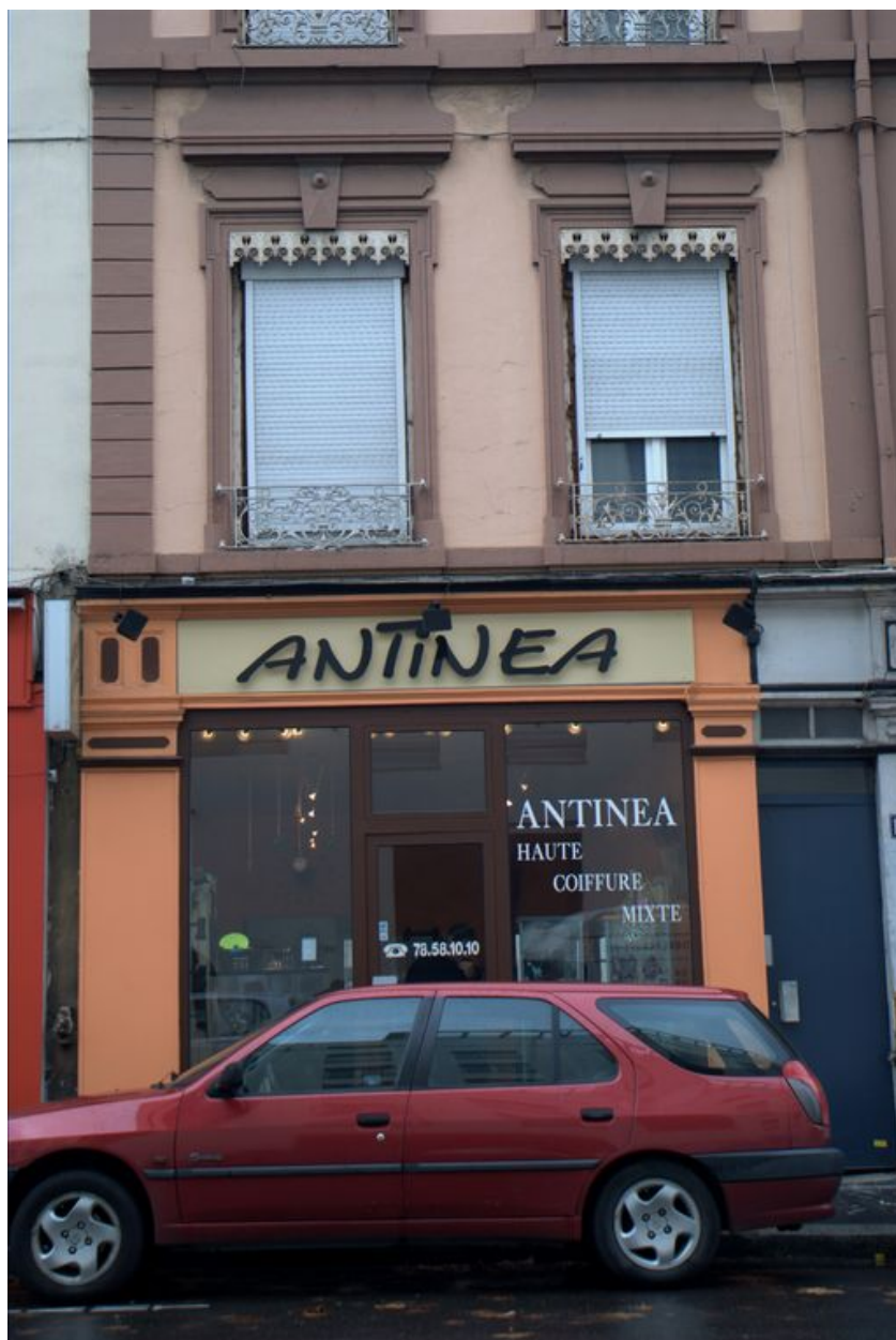
Détail de la modénature de la façade
