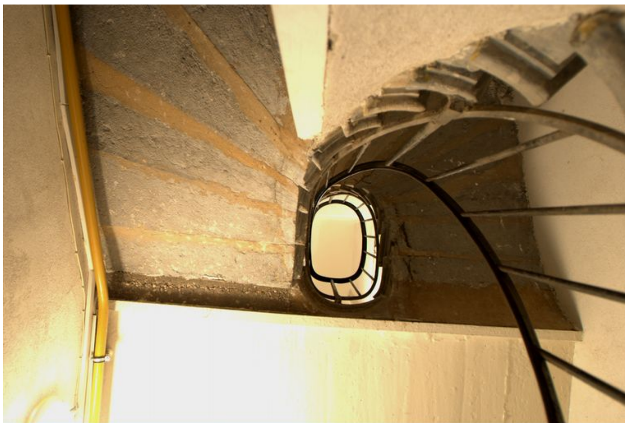
Vue de la cage d'escalier
