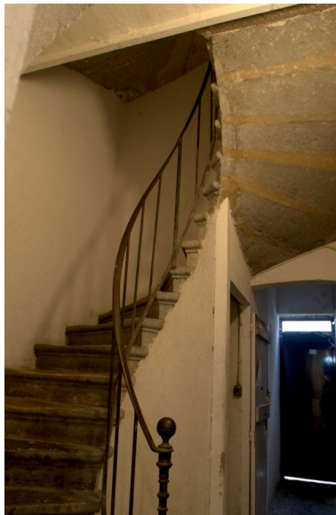
Vue de l'escalier suspendu Phot. Maryannick Chalabi IVR82_20086900833NUCA
