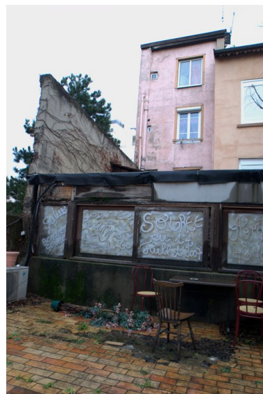
L'annexe du restaurant construite dans la cour depuis le sud-est Phot. Maryannick Chalabi
