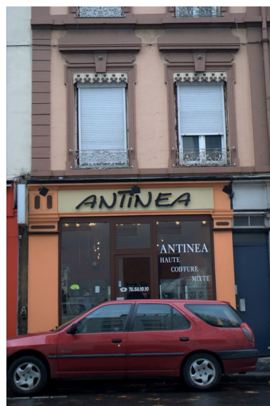
Détail de la modénature de la façade Phot. Maryannick Chalabi IVR82_20086900828NUCA
