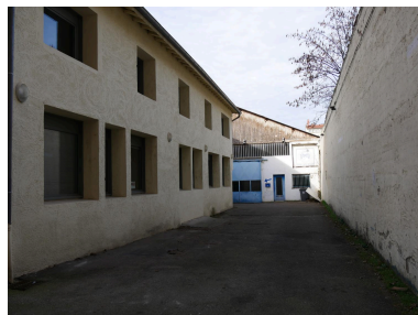
Accès au grand entrepôt Phot. Nadine Halitim-Dubois IVR84_20246900034NUCA
