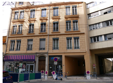
Immeuble d'entrée principale Phot. Nadine Halitim-Dubois IVR84_20246900035NUCA
